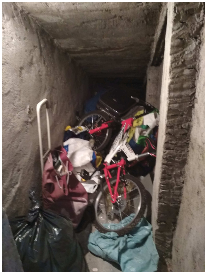
Foto n. 12 – Vano sottotetto (n. 19)
