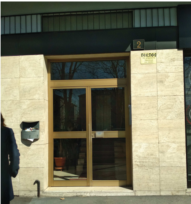
Foto n. 2 – Ingresso al fabbricato
