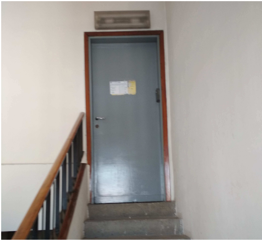
Foto n. 10 – Ingresso al sottotetto
