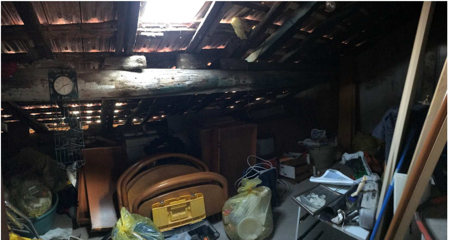
Vista interna del solaio
