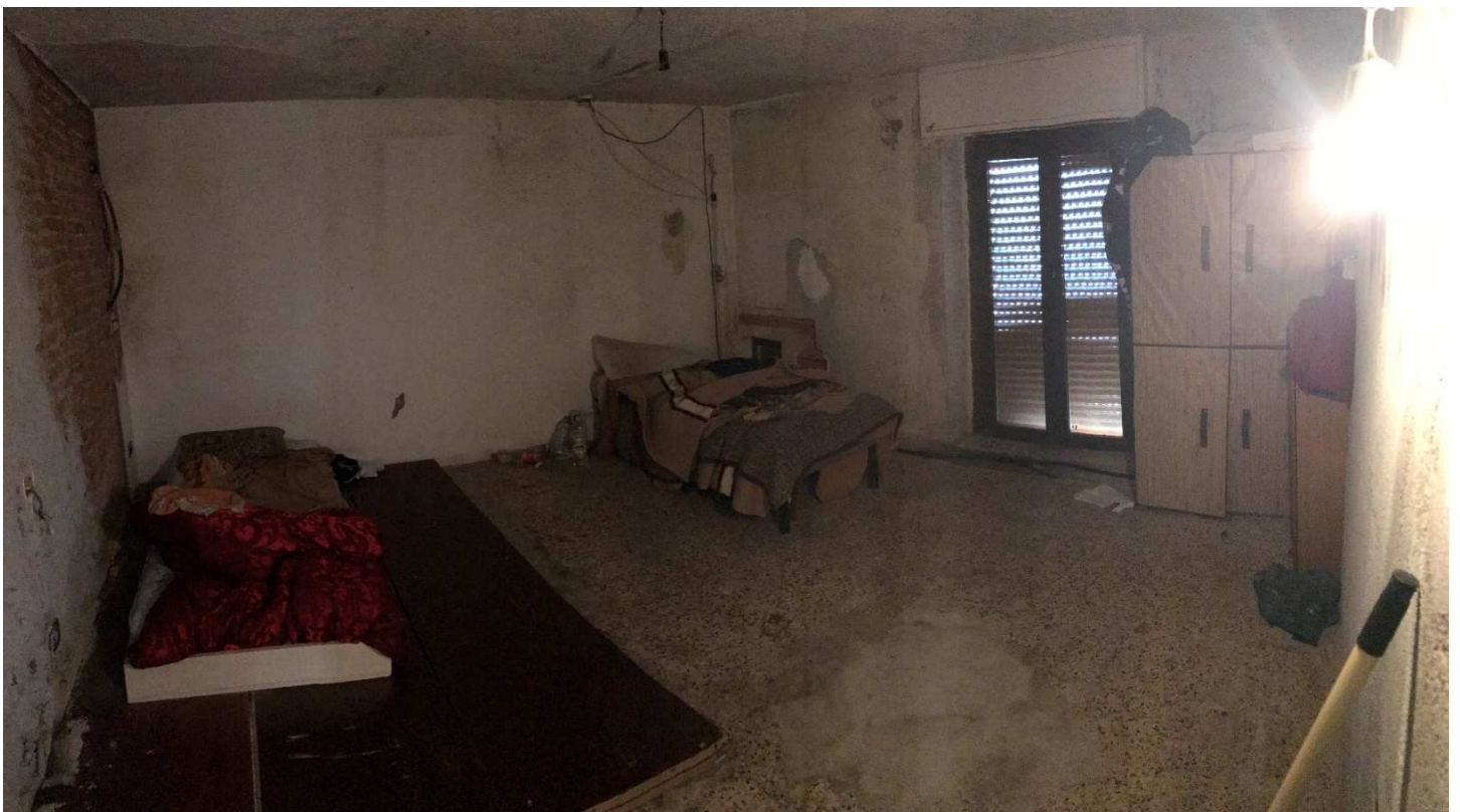
Solaio con affaccio su cortile
