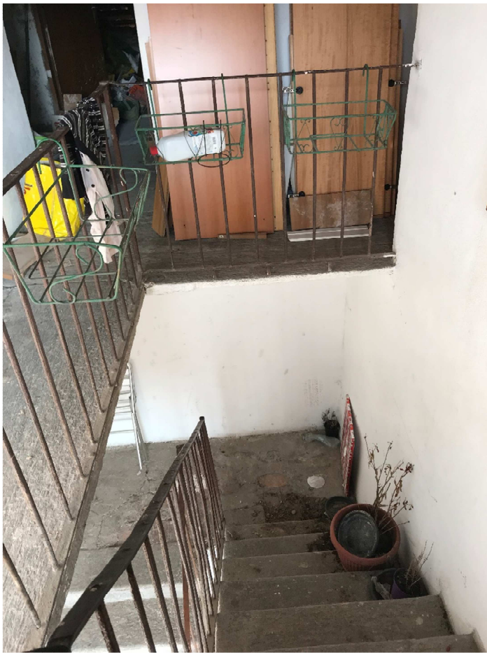
Scala di accesso al solaio
