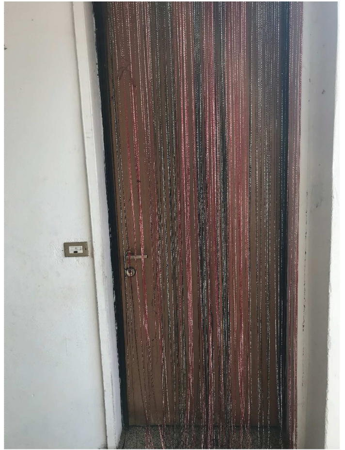
Porta ingresso all'appartamento
