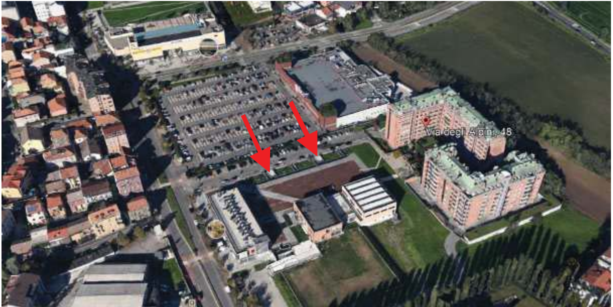
3. Rilievo fotografico del contesto. Vista aerea dell'edificio con indicazione degli accessi carrabili.
