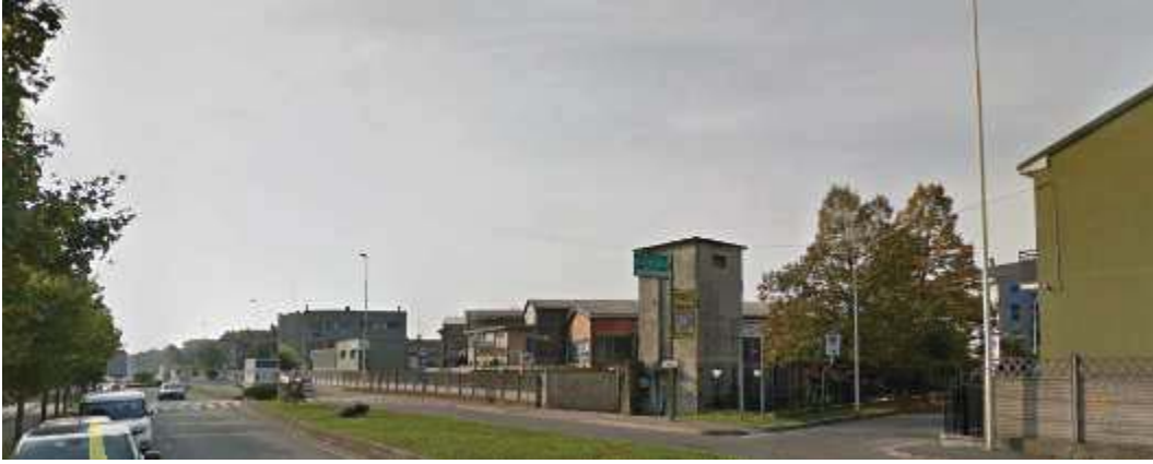
8. Vista del contesto in direzione di via Garibaldi.
