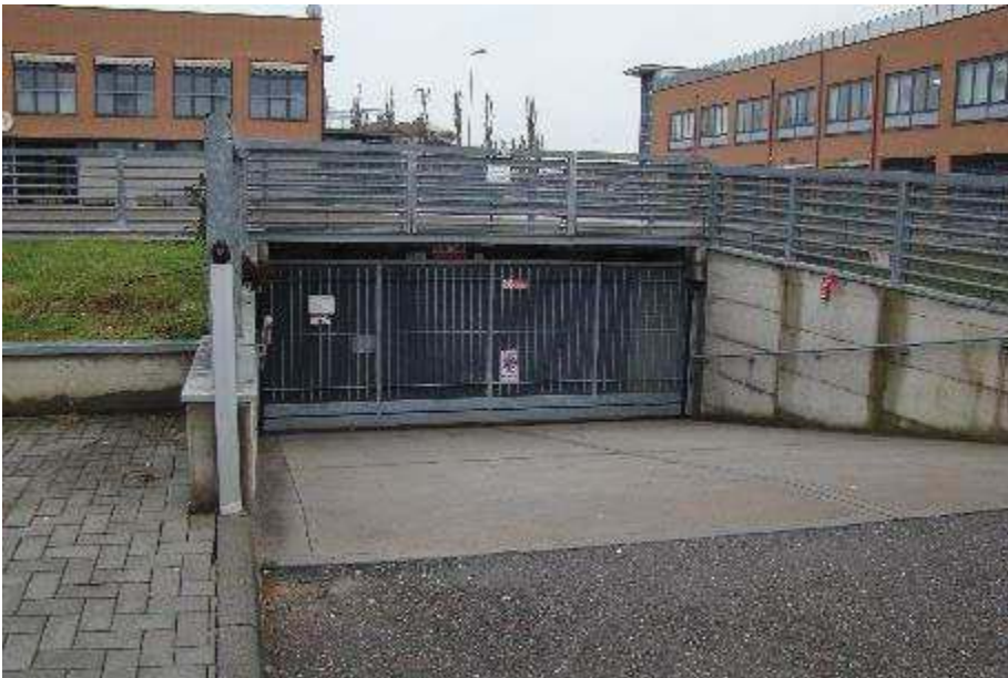
1. Vista di uno degli ingressi per l'accesso ai box interrati.
