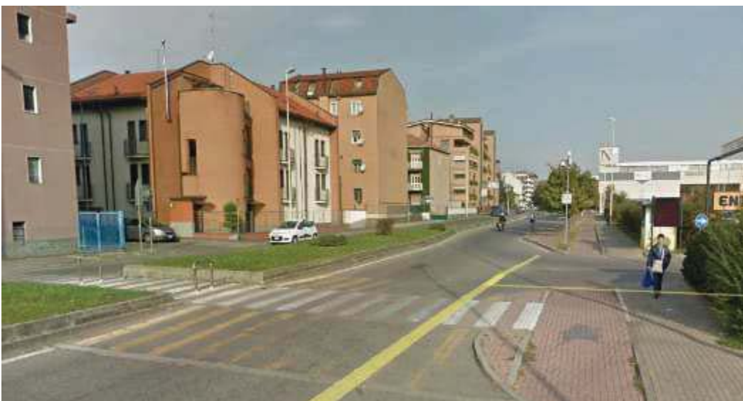
7. Vista del contesto in direzione di via Due Maggio.
