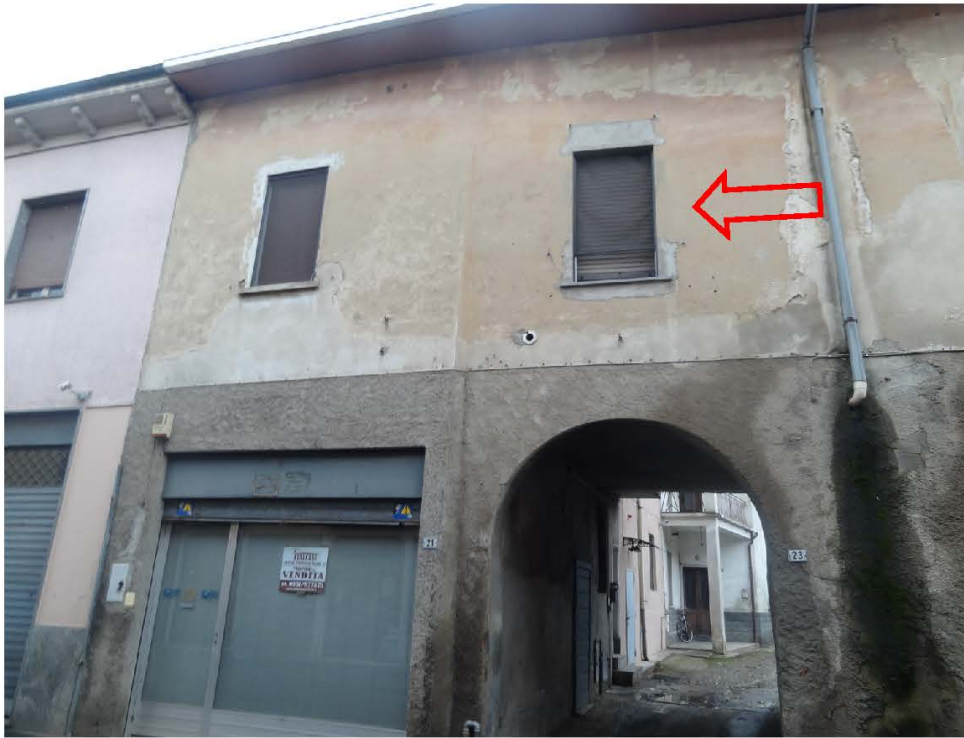
Foto esterna - ingresso corte interna fronte strada
