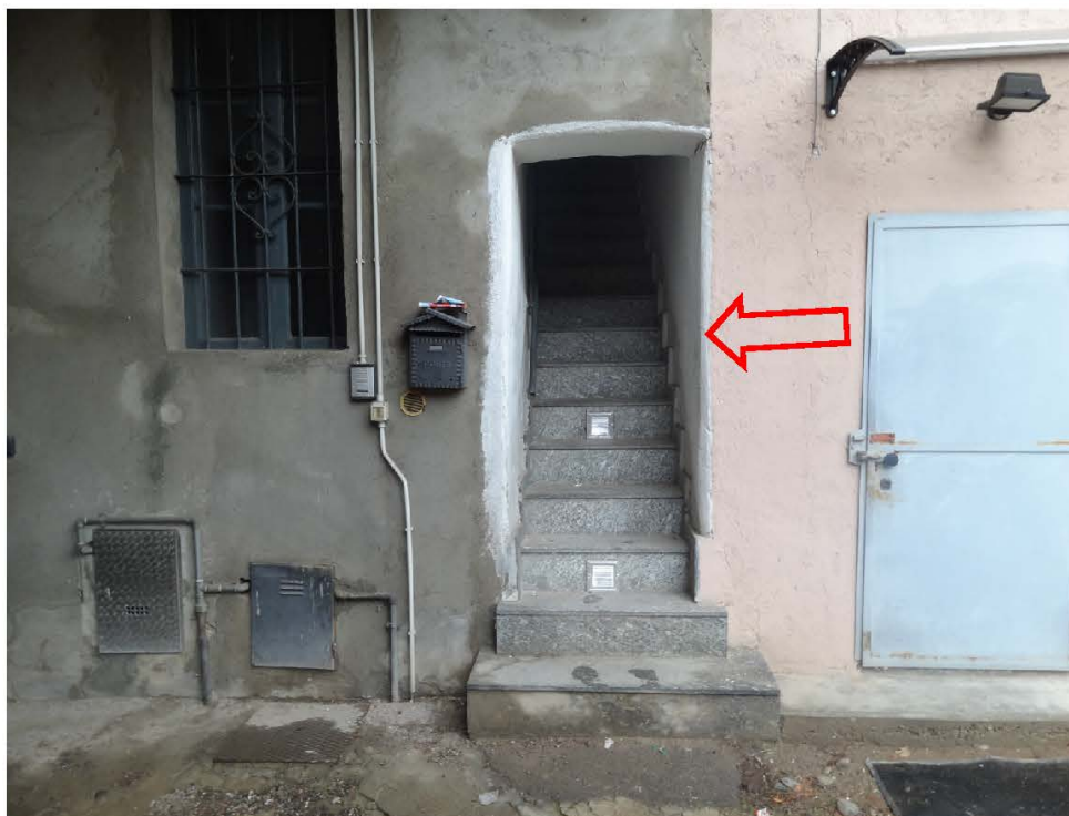
Foto esterna - scala d'accesso al cespite
