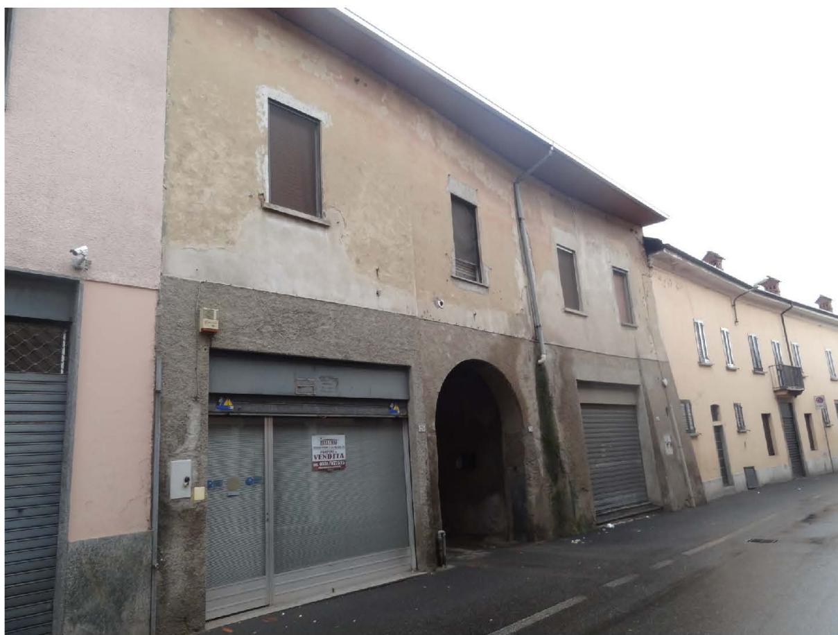
Foto esterna - Palazzina sul fronte strada
