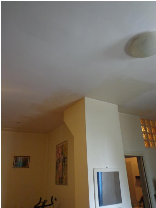
Particolari di alcuni intonaci interni, relativi al soffitto del locale giorno, rilevati in cattivo stato di conservazione (assenza di percolato); verificata la mancanza d'impianto citofono.
