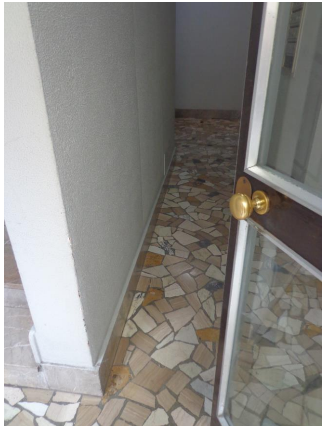
Particolari del portone d'ingresso all'atrio interno e alle parti comuni del civico n.70 int; accesso alle unità immobiliari del piano terra (rialzato) tramite corridoio condominiale (pavimentazioni realizzate in palladiana con battiscopa in marmo).
