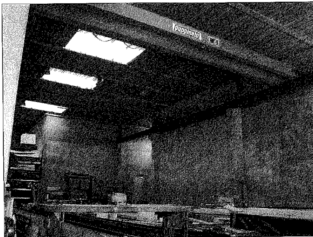
Foto n. 12: Interno laboratorio reparto calcestruzzo
