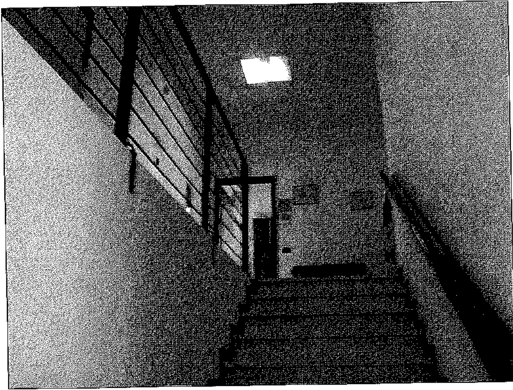
Foto n. 33: Scala interna uffici primo piano
