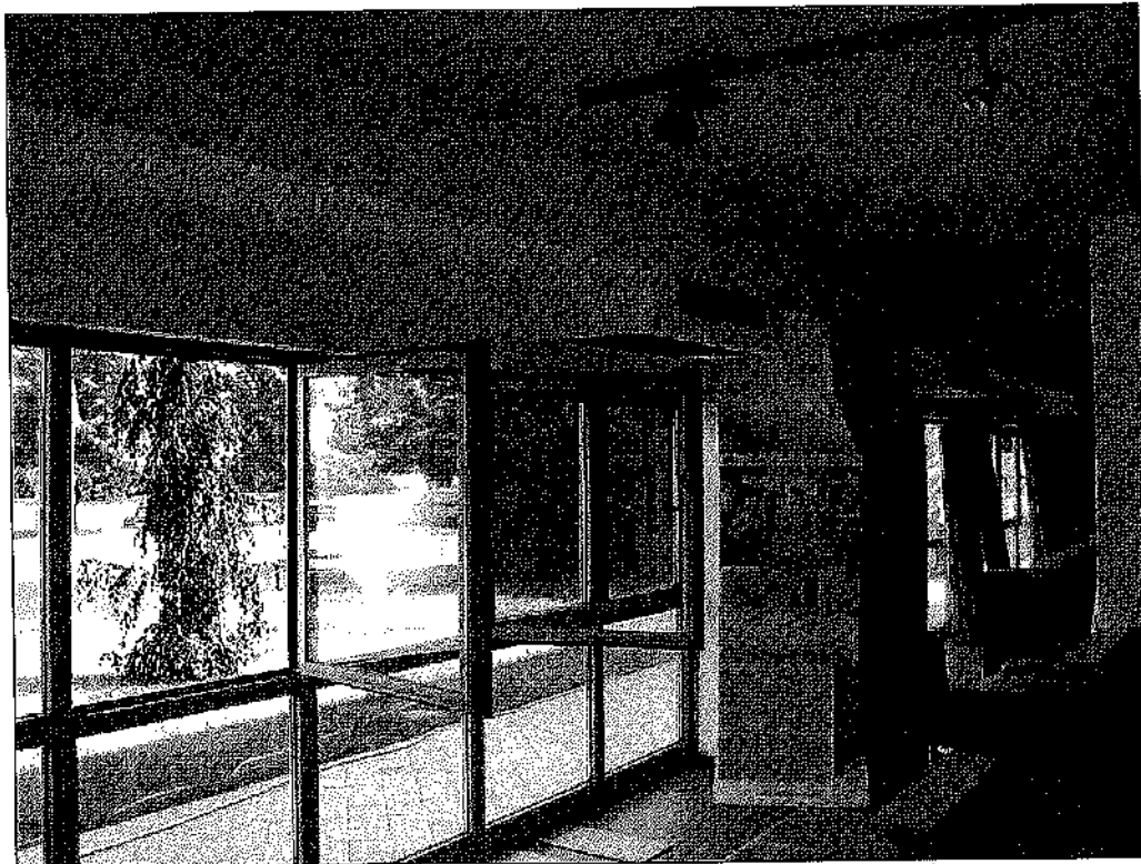
Foto n. 16: Interno piano terra
