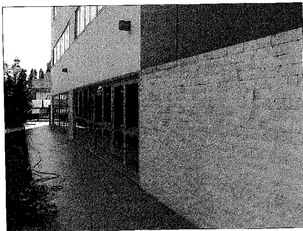
Foto n. 6: Particolare prospetto nord
