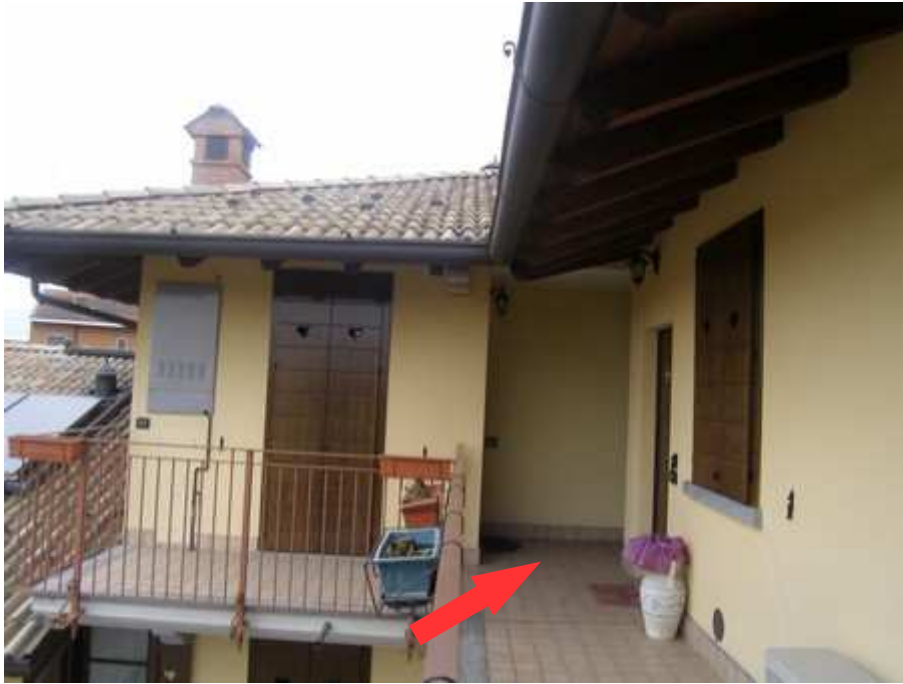
Ballatoio prospiciente il subalterno
