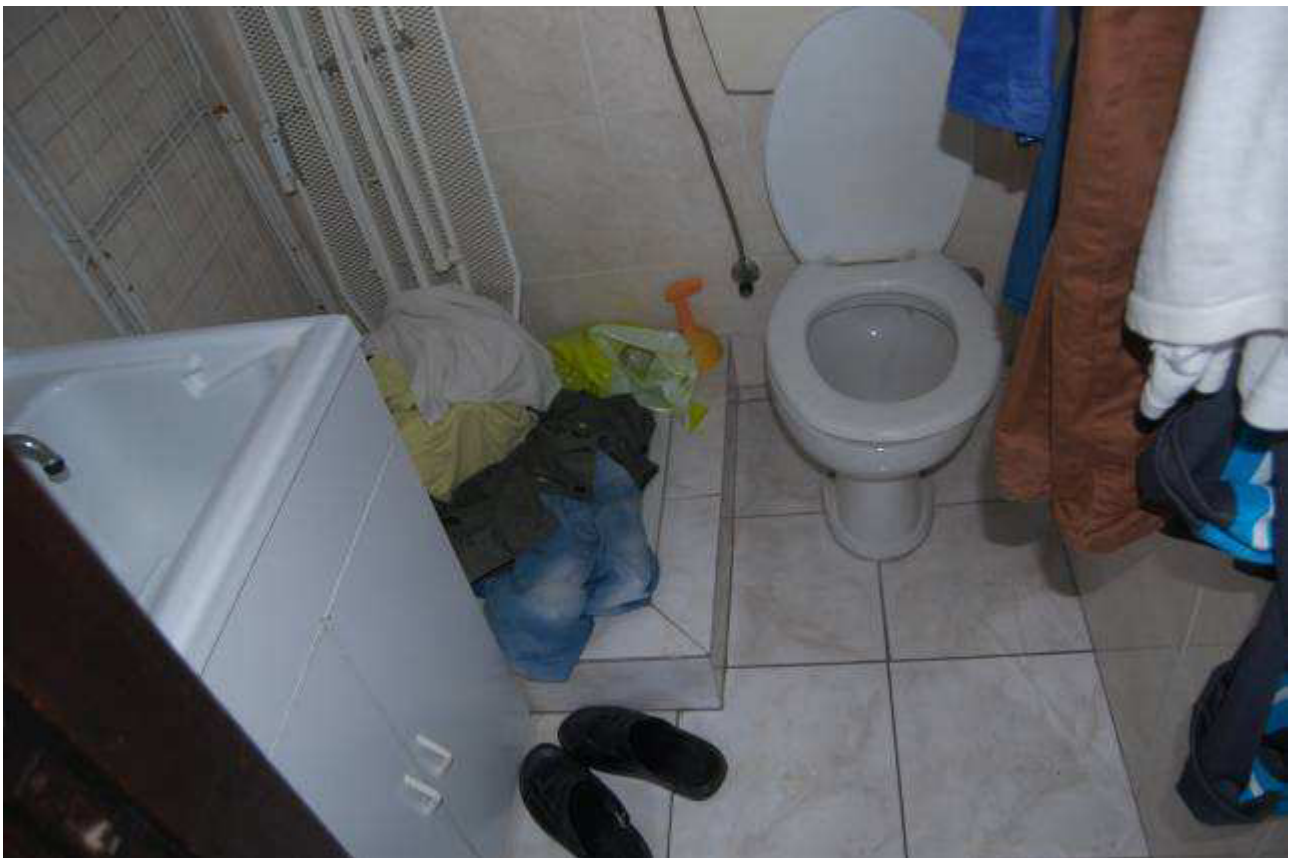
Lavanderia con doccia con altezza del soffitto 2,29 m
