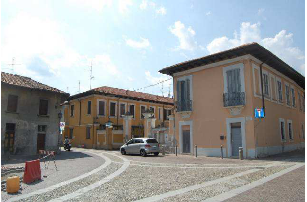
Marcallo con Casone - Contesto ambientale - Cancellone d'ingresso alla corte comune su via Milani n°2
