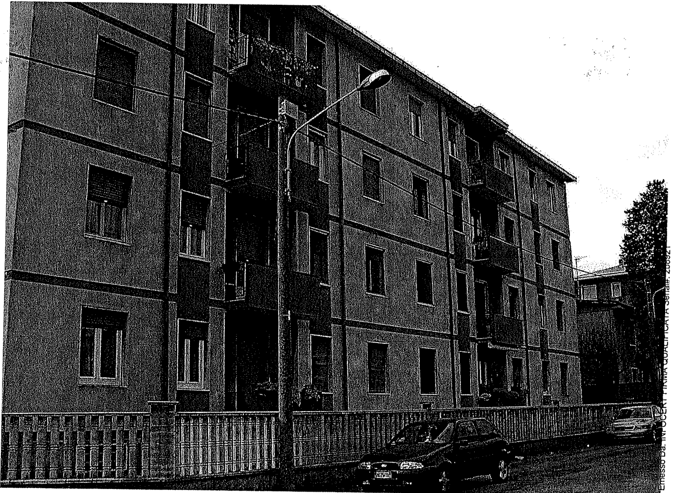
FACCIATA su via Monte Nero n.7/9 (principale) SAN VITTORE OLONA
