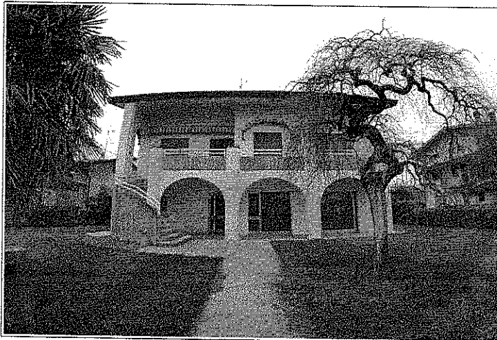
Foto 1 – vista esterna angolo nord-ovest
