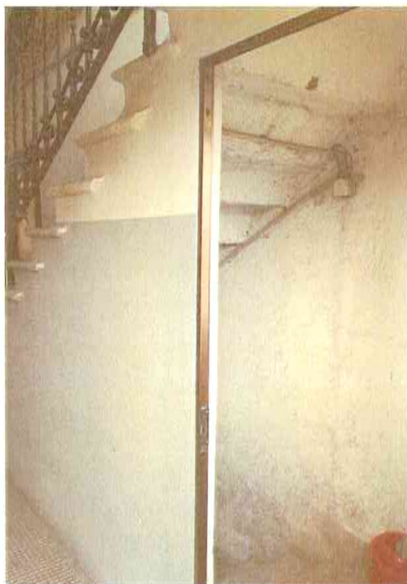
Accesso alla cantina dal passaggio comune
