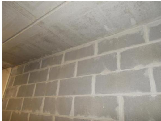
39. Particolare della parete interna del box in blocchi di calcestruzzo
