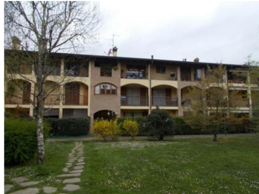
2. Facciata dell'immobile sulla corte interna
