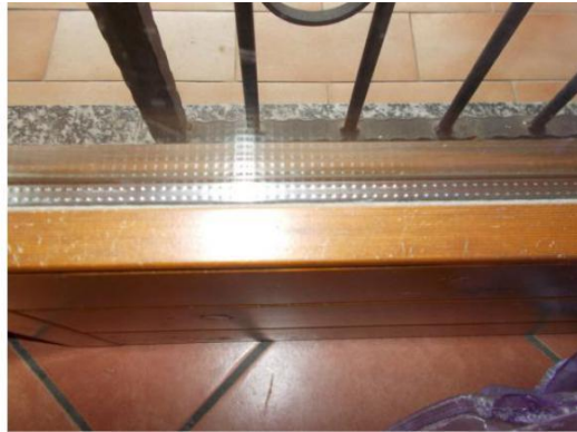
20. Particolare del serramento
