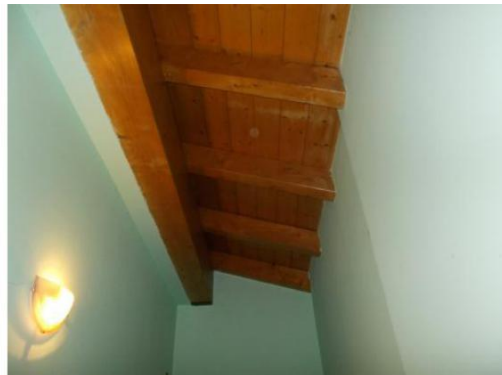
24. Particolare copertura a falde in legno del corridoio di ingresso
