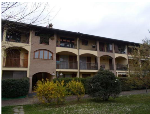
3. Facciata dell'immobile sulla corte interna
