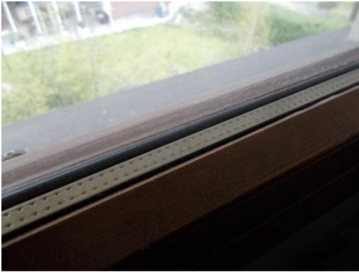
19. Particolare del serramento
