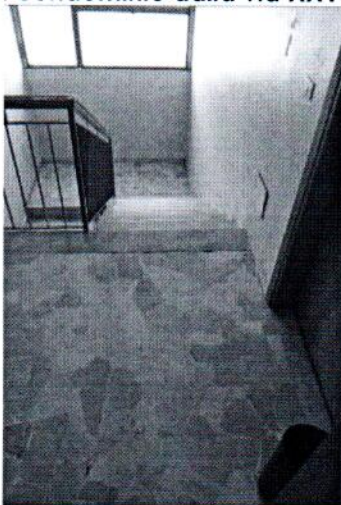
Foto 5: vano scale comune
