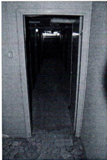
Foto 19: accesso alle cantine
