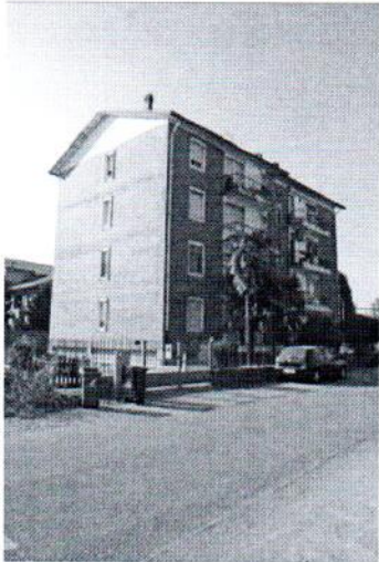
Foto 1: condominio dalla via XXV Aprile
