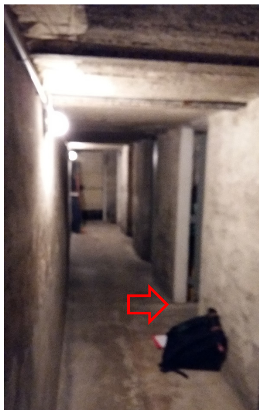
vista corridoio cantina
