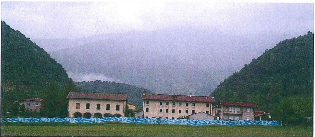
Foto n. 2: Panoramiche FABBRICATI A e B
