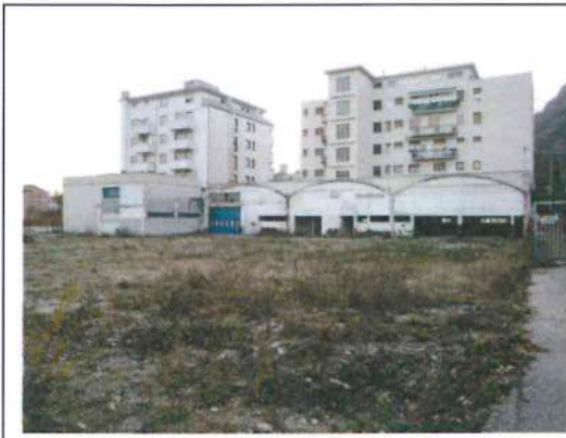
SIAV 2 e SIAV 1 vista da Est – Al piano terra lato destro si trova il magazzino in oggetto
