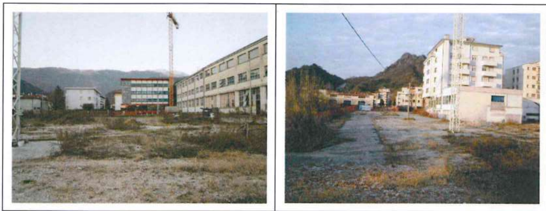
Area "Ex Fassina" vista da Ovest - In fondo fabbricato "Ariete" a destra opifici "Ex Carnielli"
