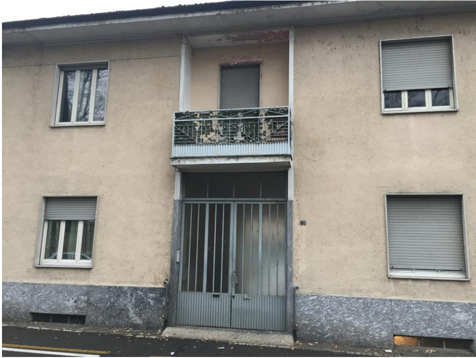
1. Foto dell'ingresso al fabbricato.
