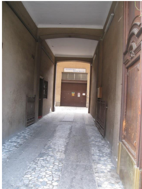
L'androne di ingresso
