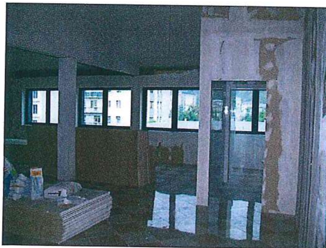
Foto n. 5: Panoramiche ufficio sub. 26
