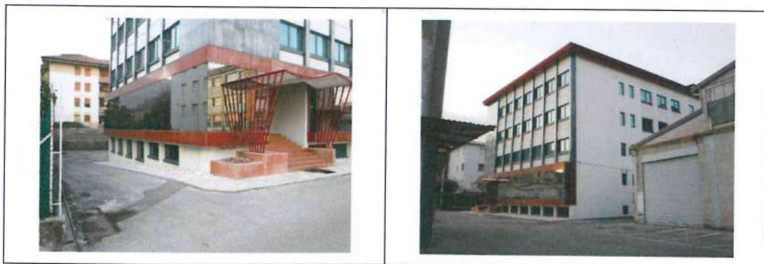
Fabbricato "Ariete" – PT uffici [REDACTED] e PS1
