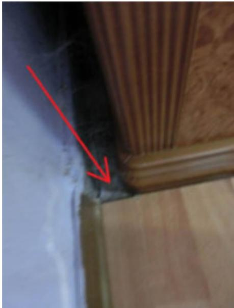
particolare pavimento sotto l'armadio e umidità di risalita
