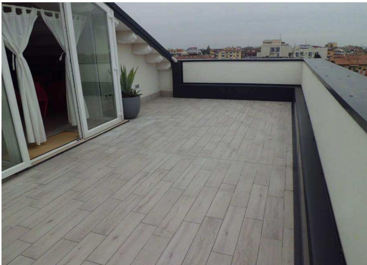
Foto n° 31 - 17/10/2016 - Comune di Caorle (VE), foglio 42, part. 905, sub. 22 - Lastrico solare esterno. Come dichiarato dalla proprietà, il pavimento e gli scoli dell'acqua del tetto sono stati ristrutturati in tempi recenti.
