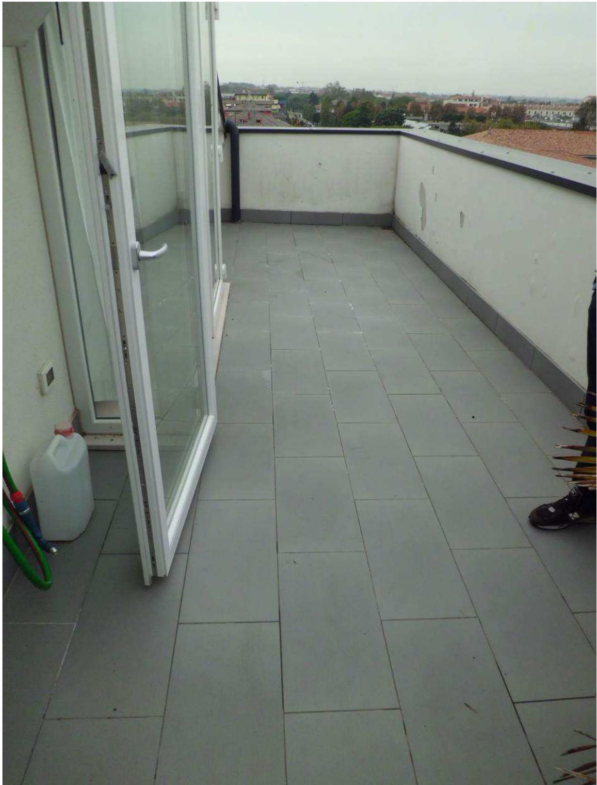
Foto n° 18 - 17/10/2016 - Comune di Caorle (VE), foglio 42, part. 905, sub.23 - Lastrico solare esterno. Come visibile il muro risulta scrostato in diversi punti.
