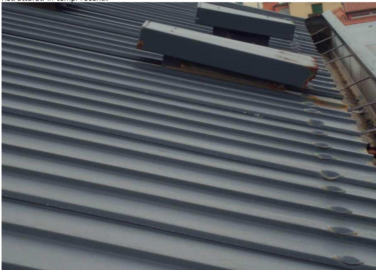
Foto n° 32 - 17/10/2016 - Comune di Caorle (VE), foglio 42, part. 905, sub. 22 - Particolare del tetto di copertura condominiale. Si evidenziano delle iniziali corrosioni in alcuni punti.
