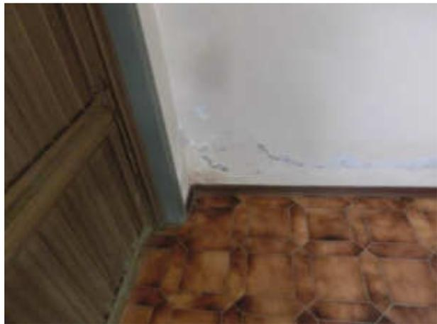
ulteriore particolare umidità di risalita in garage
