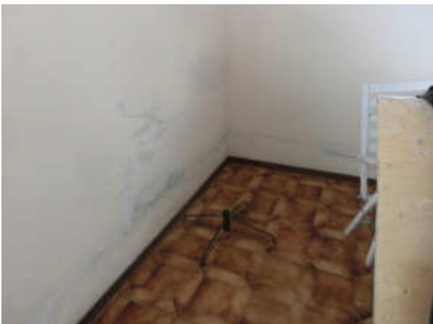
ulteriore particolare umidità di risalita in garage
