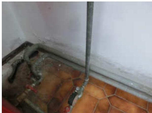
ulteriore particolare umidità di risalita in centrale termica
