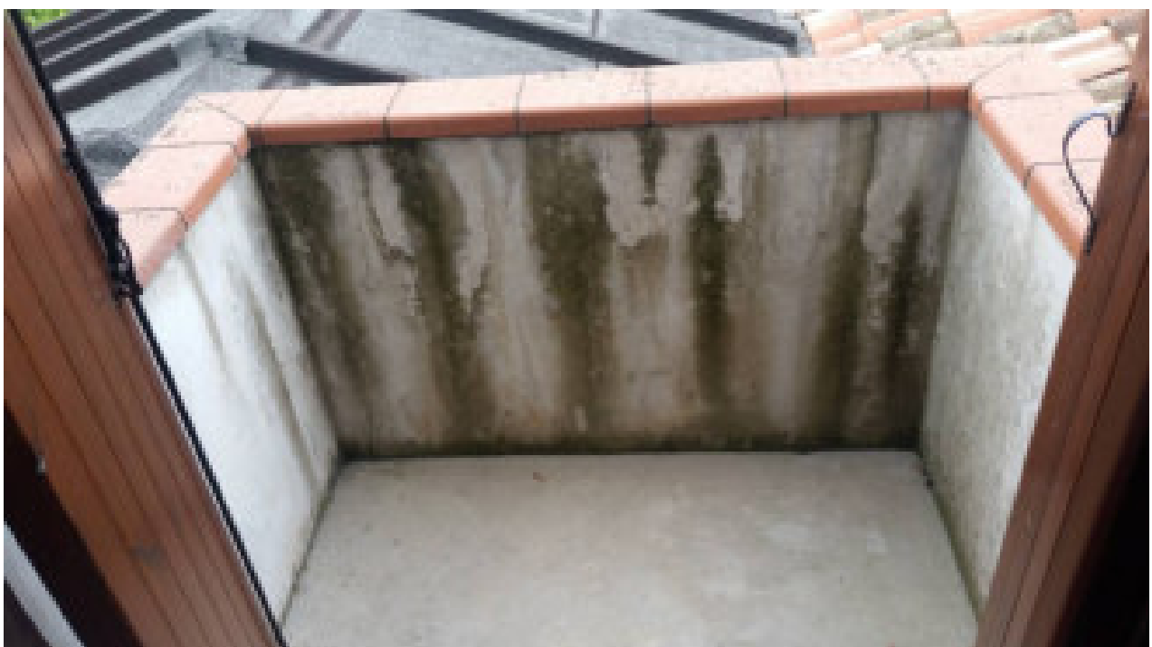
Foto 23 - terrazzo del bagno al piano primo
