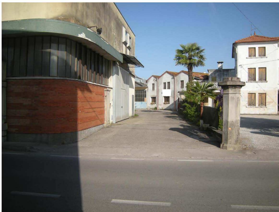
Prata di Pordenone, Particella 629 – L'accesso all'immobile da via Leonardo Da Vinci.
