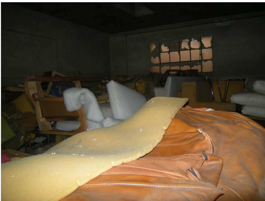
Prata di Pordenone, Particella 629 – Il locale con destinazione d'uso verniciatura.
