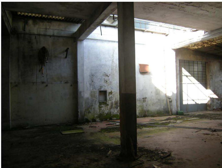
Prata di Pordenone, Particella 629 – Il locale con destinazione d'uso Officina.
