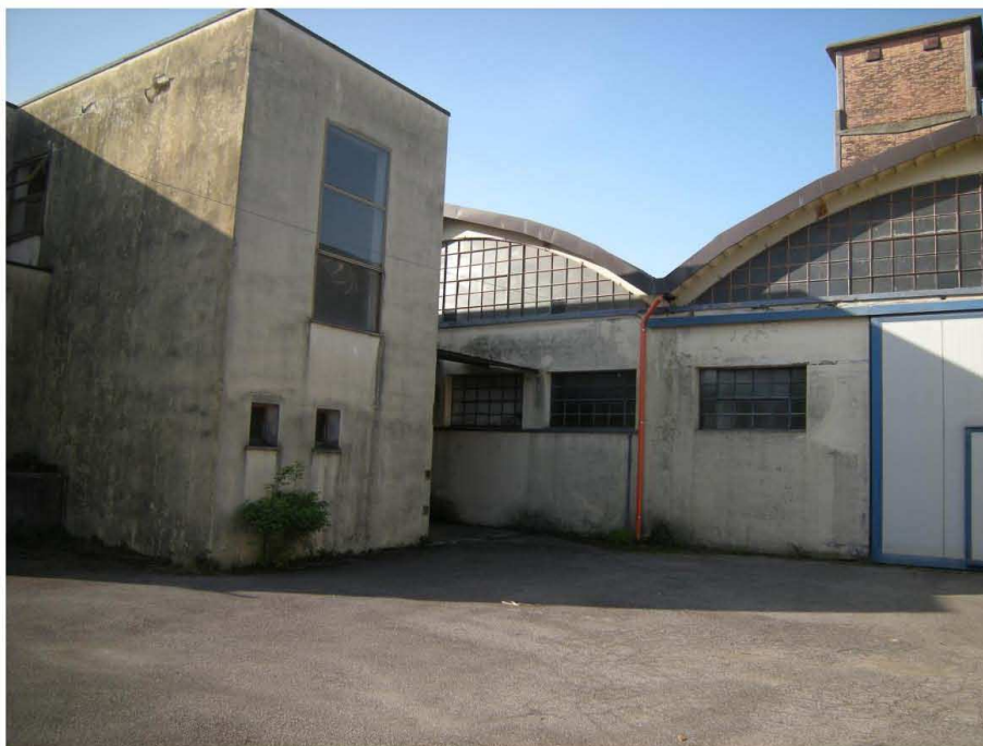
Prata di Pordenone, Particella 629 – La corte esterna.
