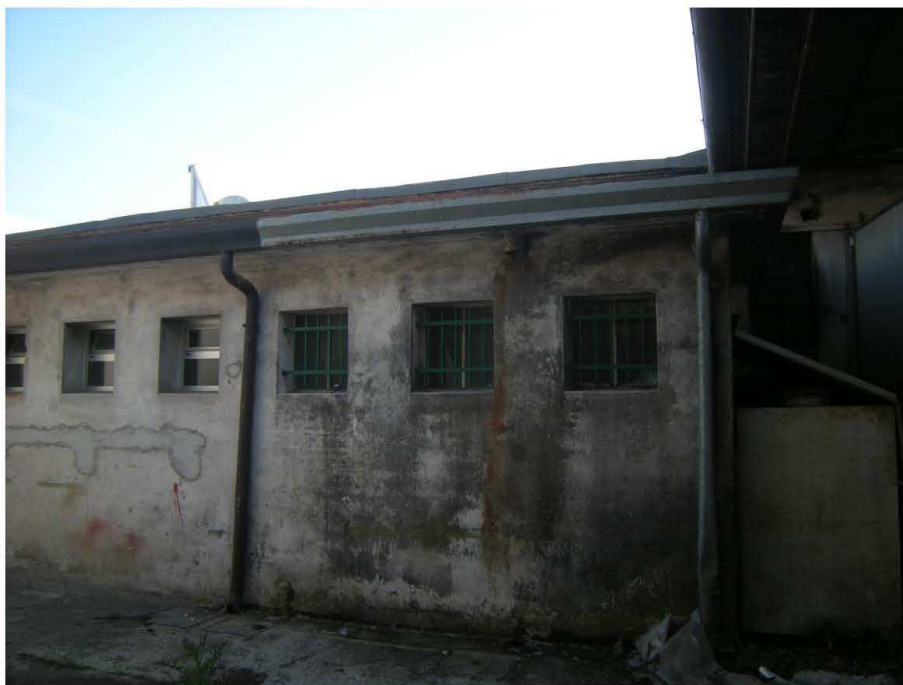
Prata di Pordenone, Particella 629 – Il prospetto del Capannone a sud -ovest.
