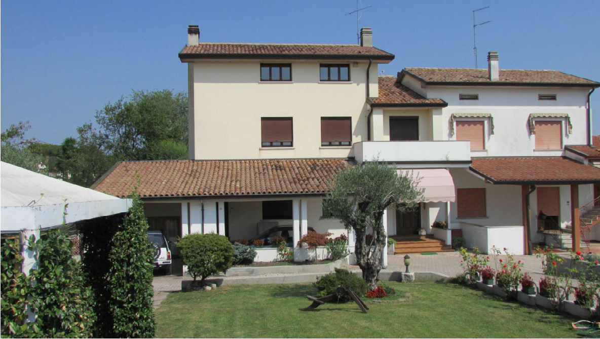
Foto della facciata Ovest del fabbricato
