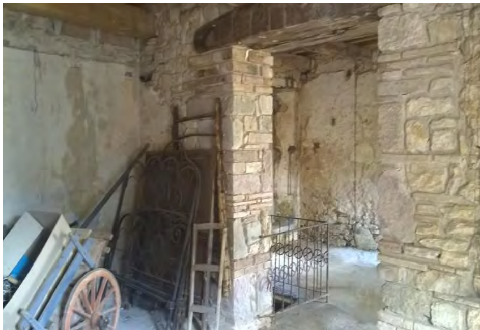
Foto n. 05: vista interna locale (Fg. 163, p.IIa 51) – apertura/fusione con p.IIa 205 (n. 2 locali posti al p. 1°)
