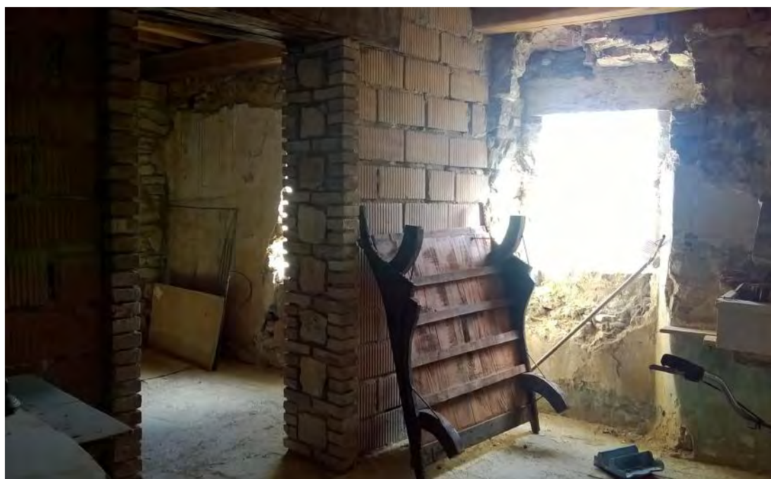
Foto n. 07: vista interna locali (Fg. 163, p.IIa 51)
