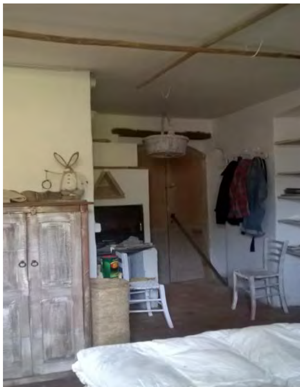
Foto n. 09: camera p.lla 48 sub. 3 (p.1)
