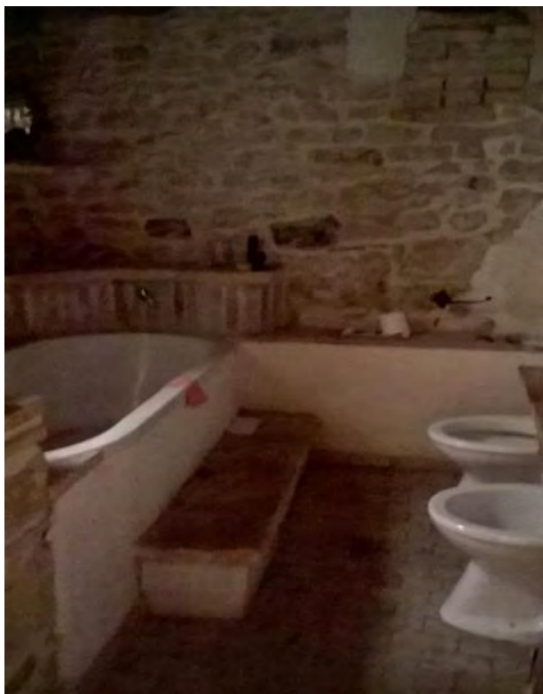
Foto n. 08: servizio igienico p.lla 48 sub. 4
