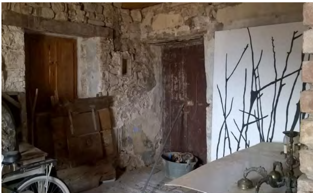
Foto n. 06: vista interna locali (Fg. 163, p.IIa 51) – ingresso esterno
