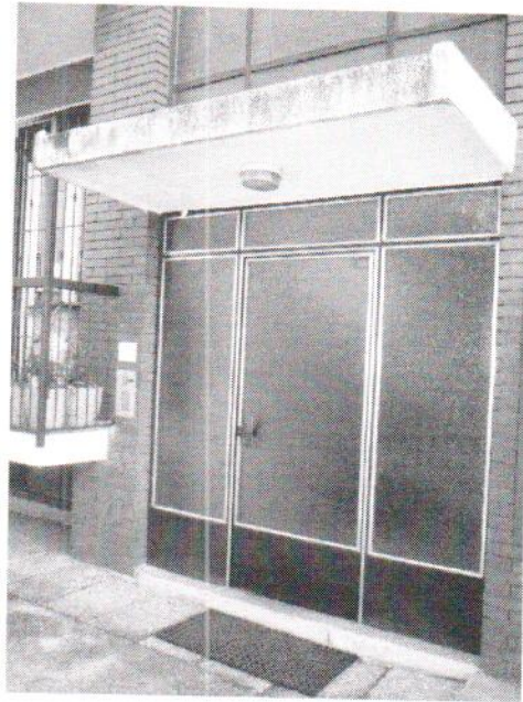
Ingresso al fabbricato
