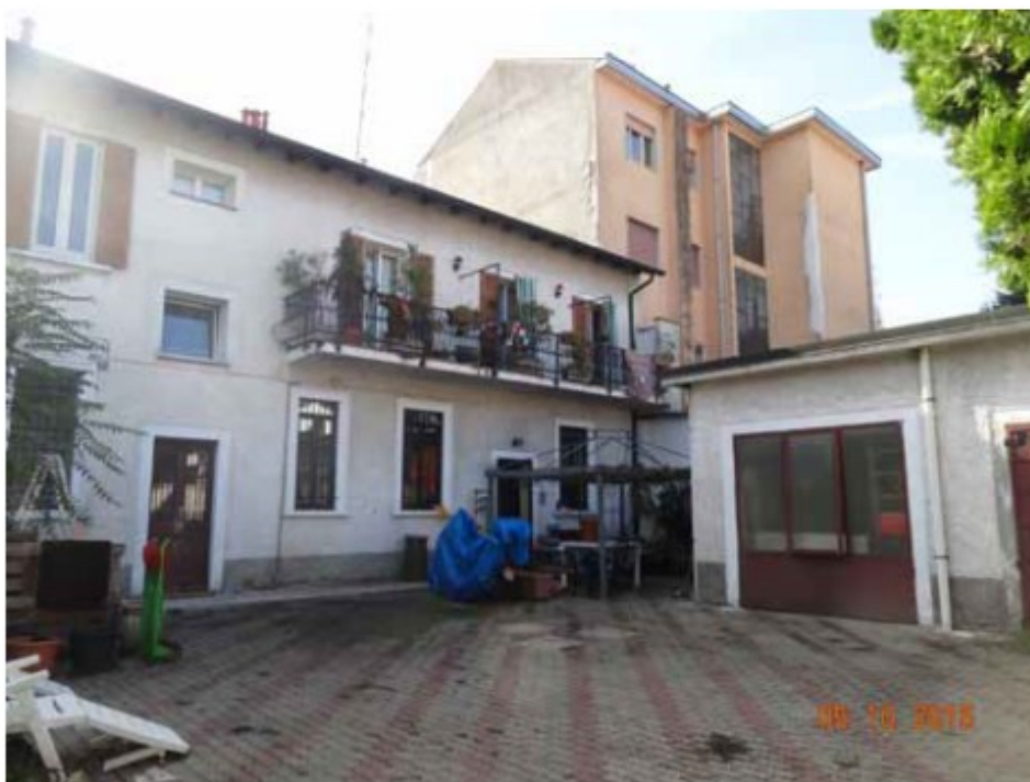
Vista esterna - in evidenza box trasformato in deposito esterno
