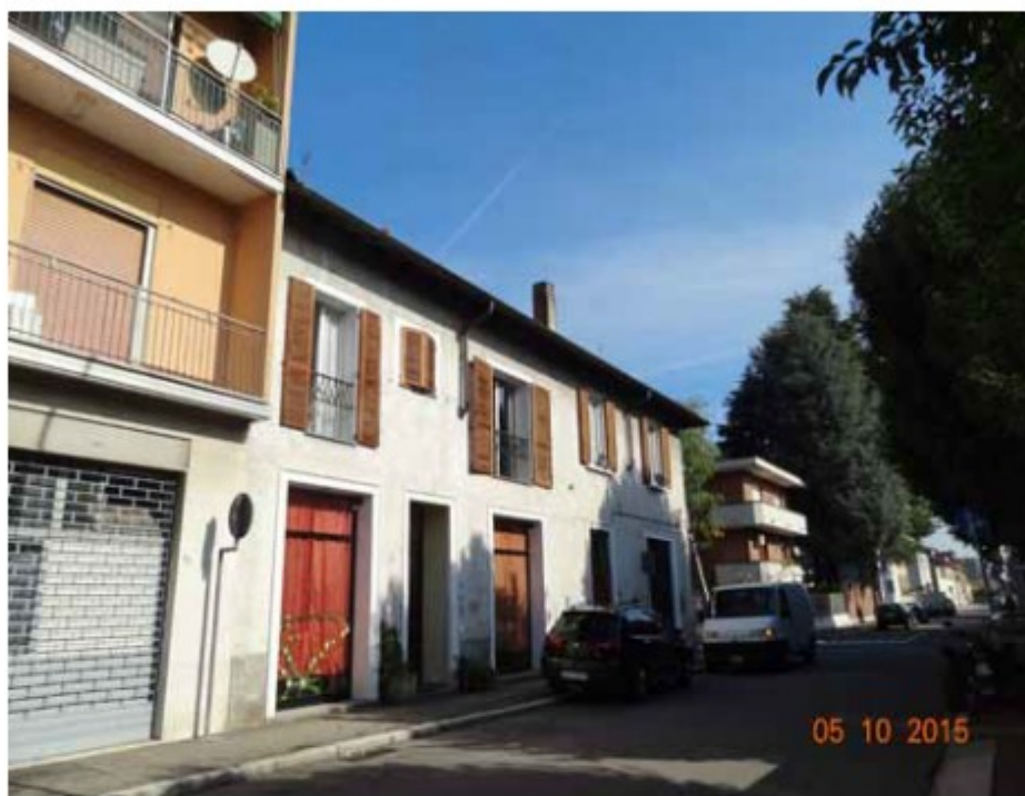
Vista esterna - ingresso pedonale fronte strada
