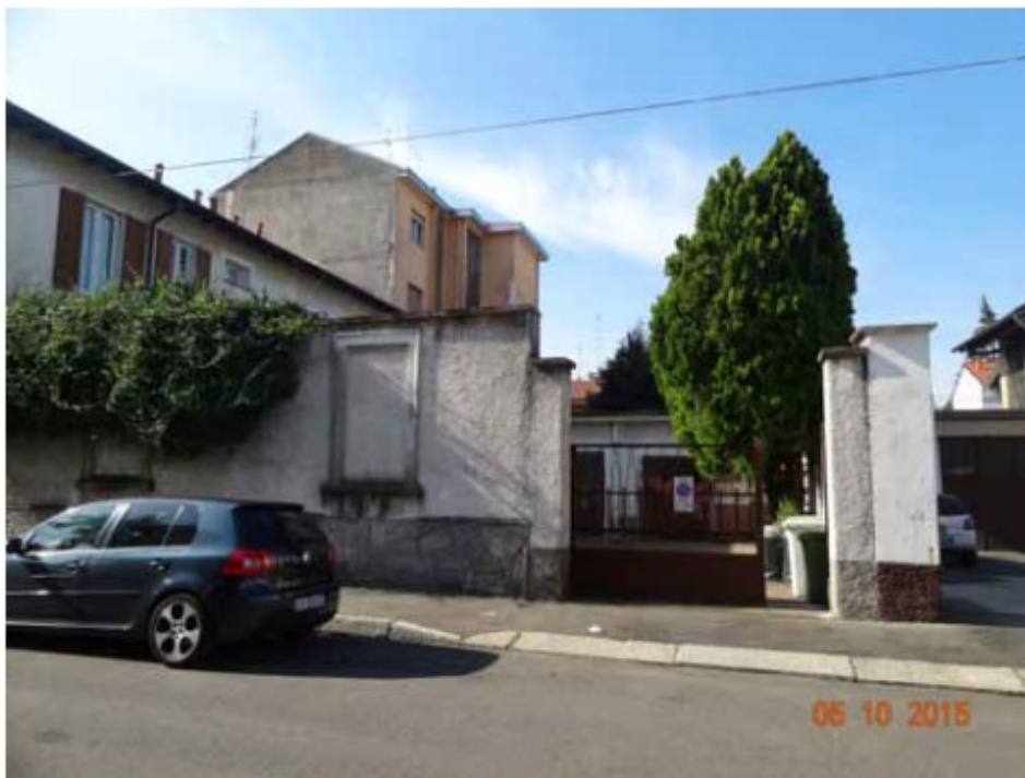
Vista esterna - ingresso carraio
