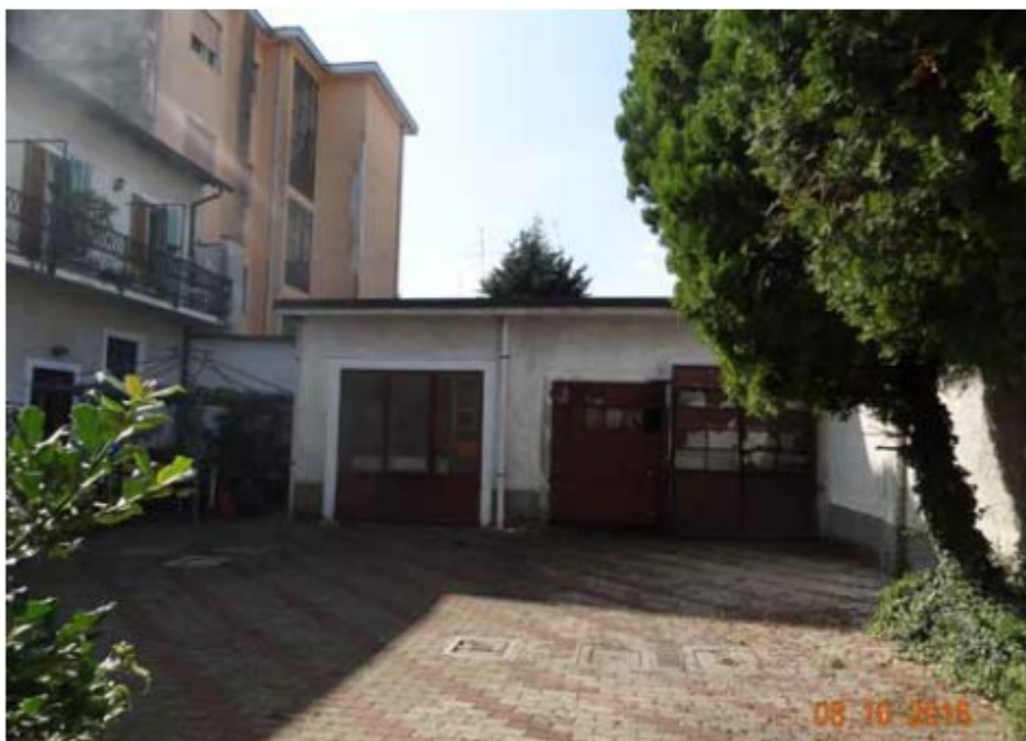
Vista esterna - cortile comune
