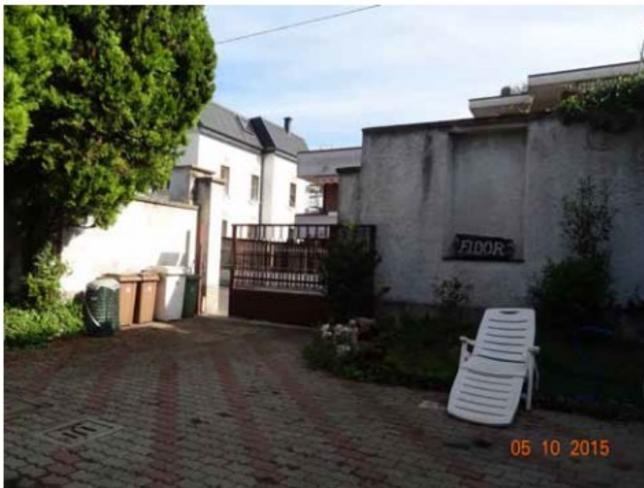
Vista esterna - cortile comune in evidenza spazio riservato ai posti auto del negozio adibiti ad aiuola
