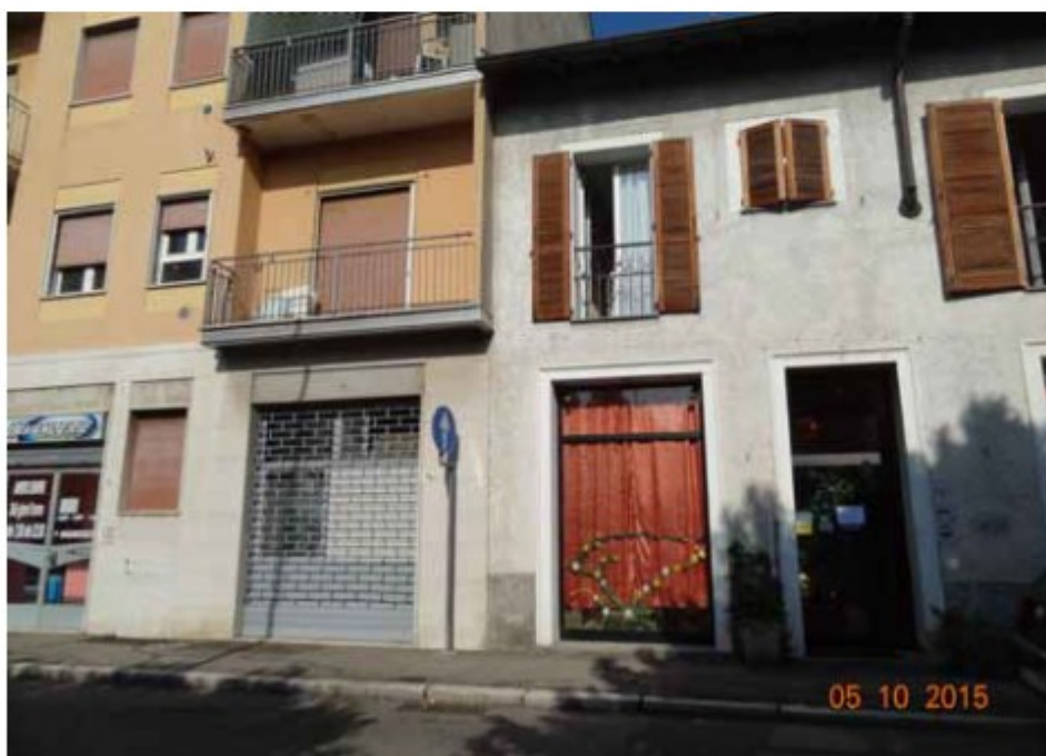
Vista esterna - ingresso pedonale fronte strada
