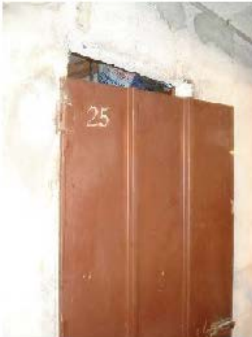
Porta di ingresso al locale piano S-1
