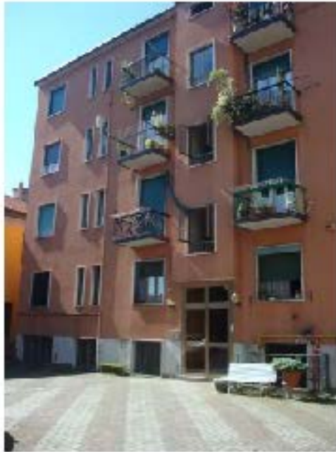
VIA PISTOIA, 17 - PALAZZINA INTERNA
