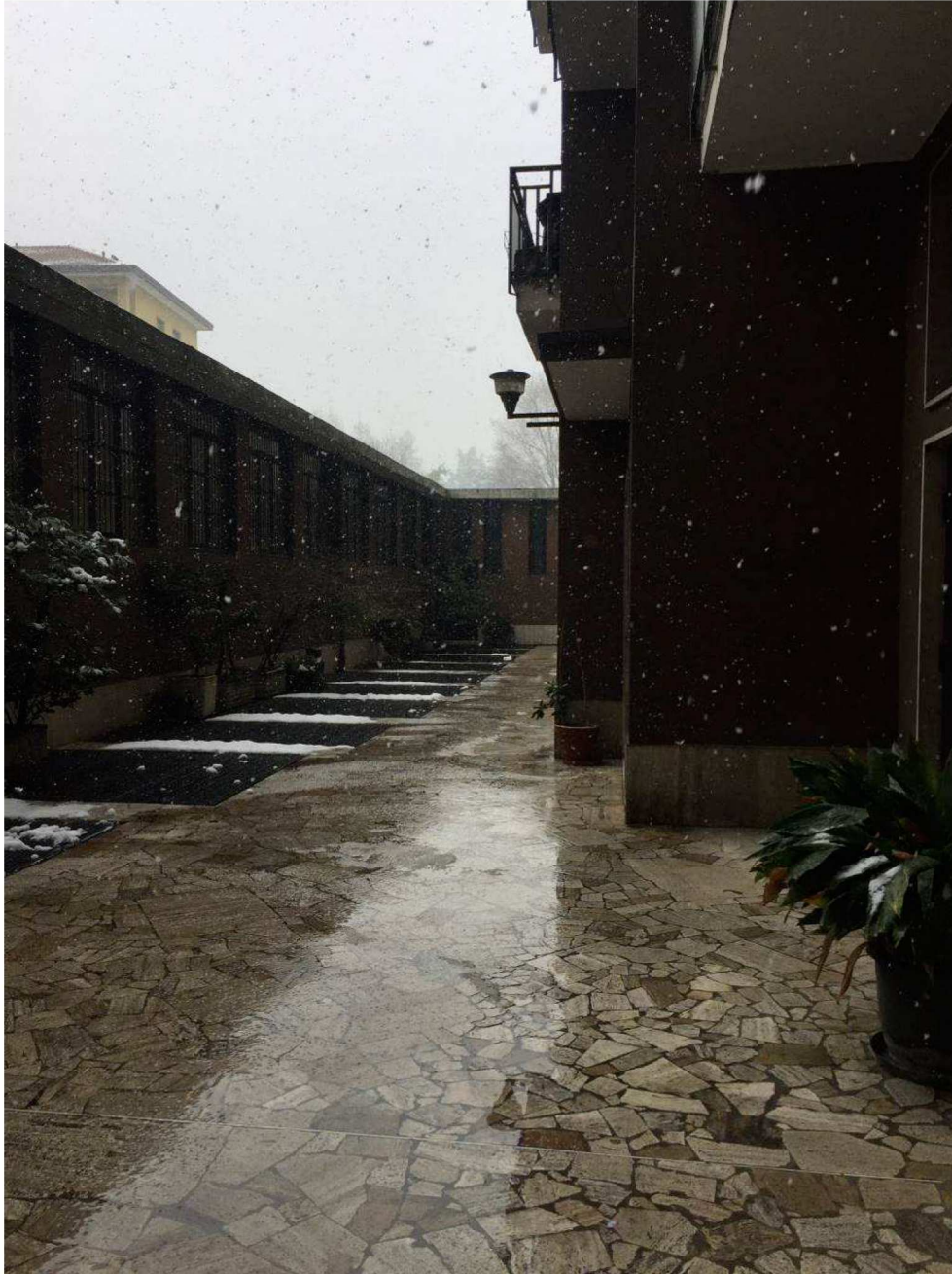
Fotografia n. 8 – Vista del percorso esterno del Condominio di Via Lessona n. 2, Milano, che conduce alla Scala D, dove, al piano secondo, si trova l'appartamento di proprietà degli esecutati
