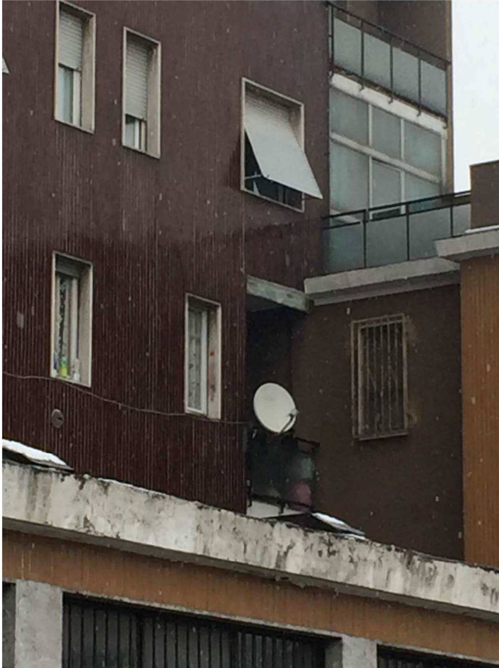
Fotografia n. 3 – Particolare del prospetto su Via Antonio Aldini, del Condominio di Via Lessona n. 2, Milano, dove, al piano secondo, si trovano gli affacci delle finestre e della loggia dell'appartamento di proprietà dei debitori esecutati
