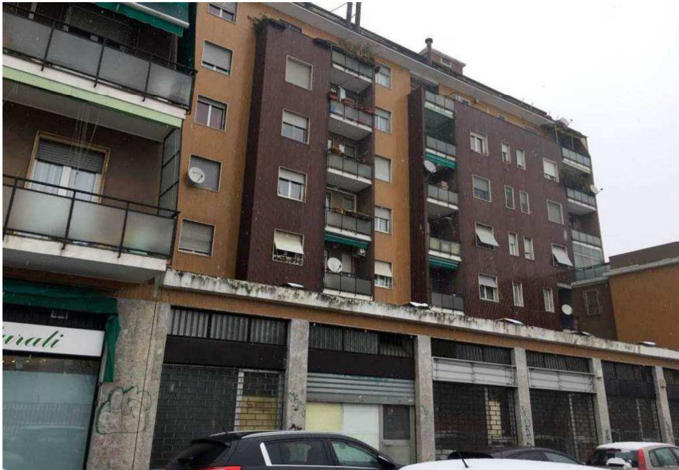
Fotografia n. 2 – Vista del Condominio di Via Lessona n. 2, Milano - prospetto su Via Antonio Aldini, dove, al piano secondo, si trovano gli affacci delle finestre e della loggia dell'appartamento di proprietà dei debitori esecutati
