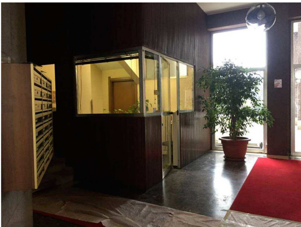
Fotografia n. 7 – Particolare della portineria del Condominio di Via Lessona n. 2, Milano
