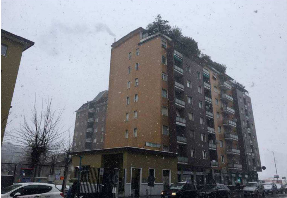
Fotografia n. 1 – Vista del Condominio di Via Lessona n. 2, Milano – prospetto su Via Michele Lessona
