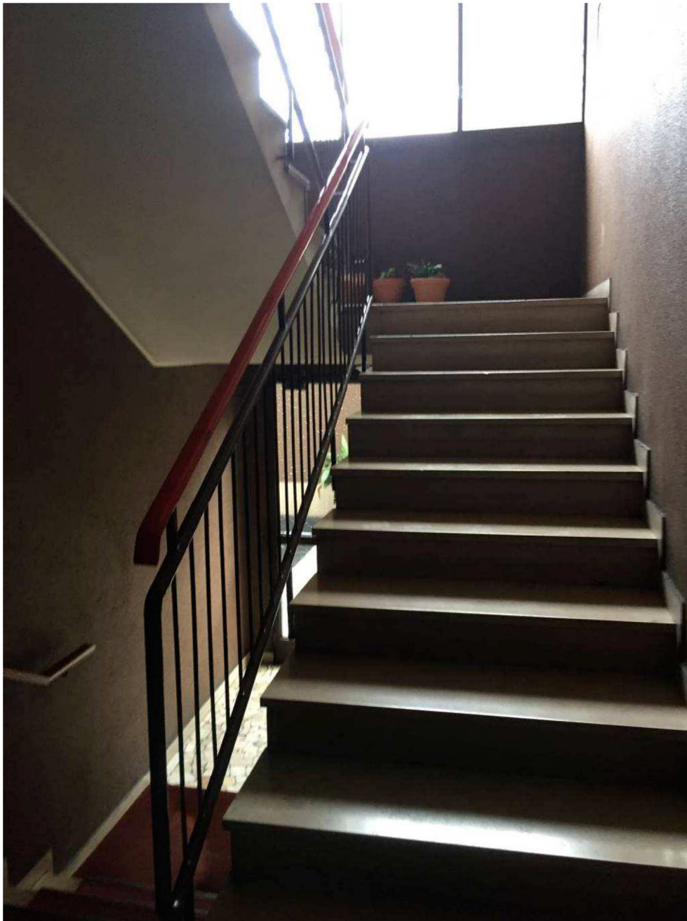
Fotografia n. 15 – Particolare della rampa di scale della Scala D, che conduce all'appartamento di proprietà degli esecutati al piano secondo
