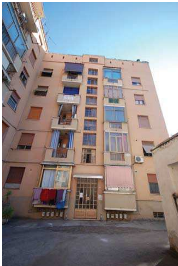
Foto 05_ Palazzina denominata "SCALA D"
