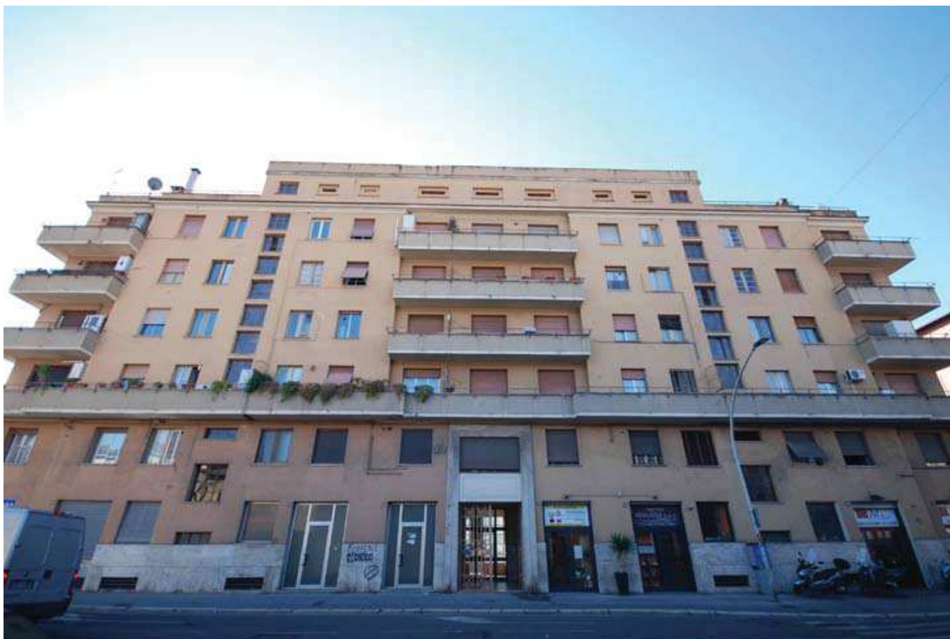
Foto 02_ Facciata del Complesso condominiale con ingresso da Viale Brin
