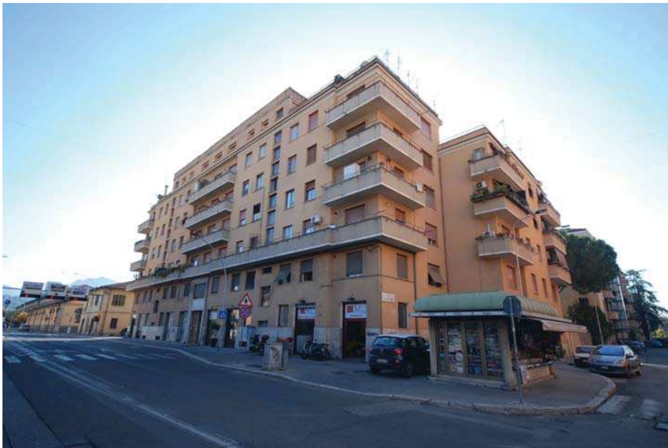
Foto 01_ Complesso condominiale visto da Viale Brin
