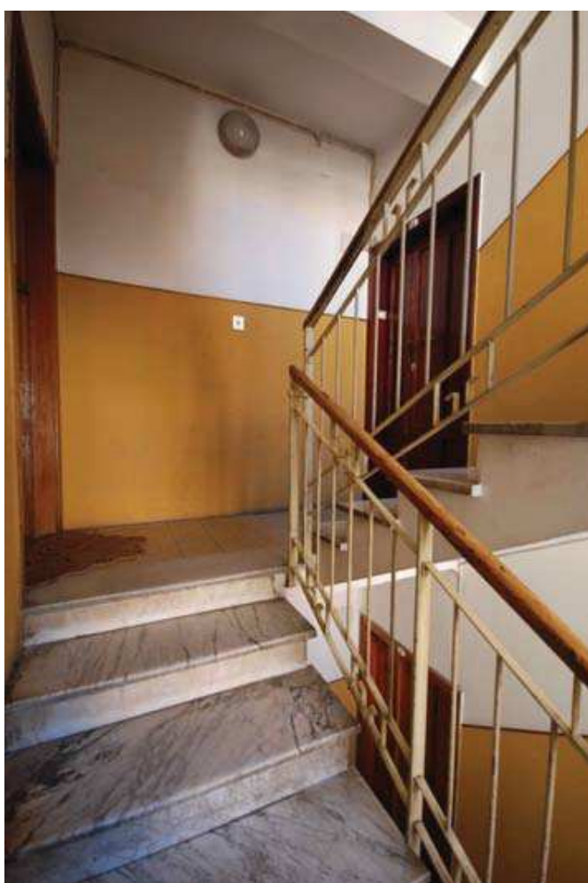
Foto 08_ Vista della scala condominiale
