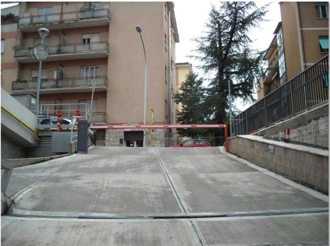
Foto 2 – Corsia ingresso autorimessa
