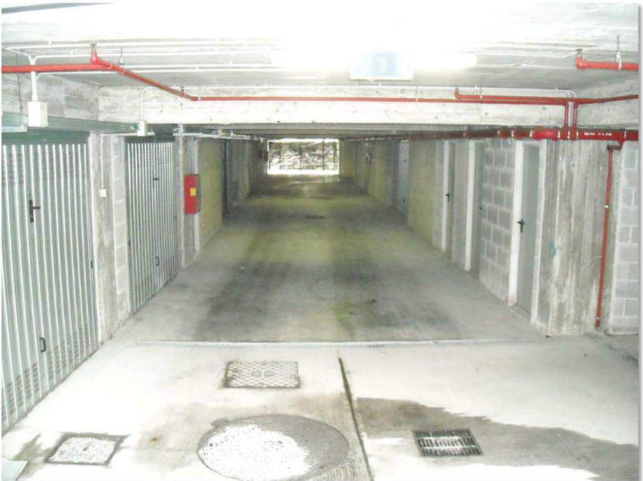
Foto 4 – Corsia ingresso autorimessa
