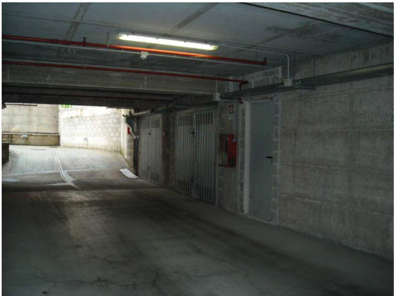
Foto 6 – Corsia ingresso autorimessa
