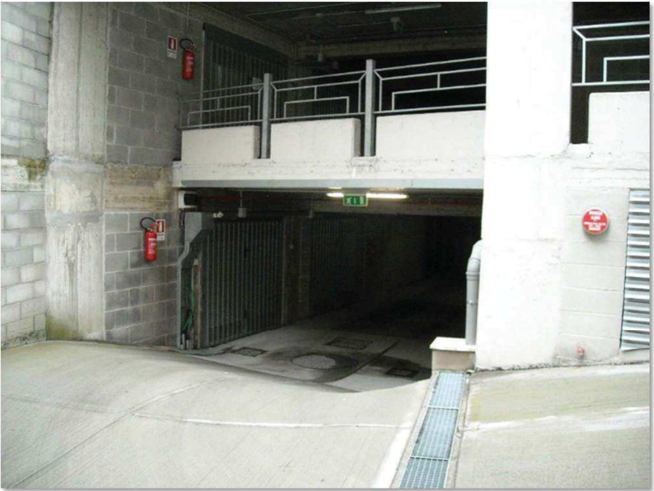
Foto 3 – Corsia ingresso autorimessa
