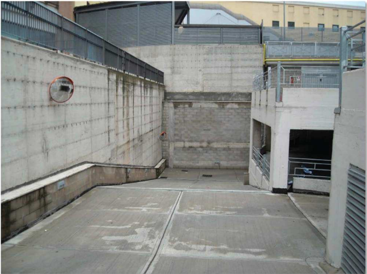
Foto 1 – Corsia ingresso autorimessa
