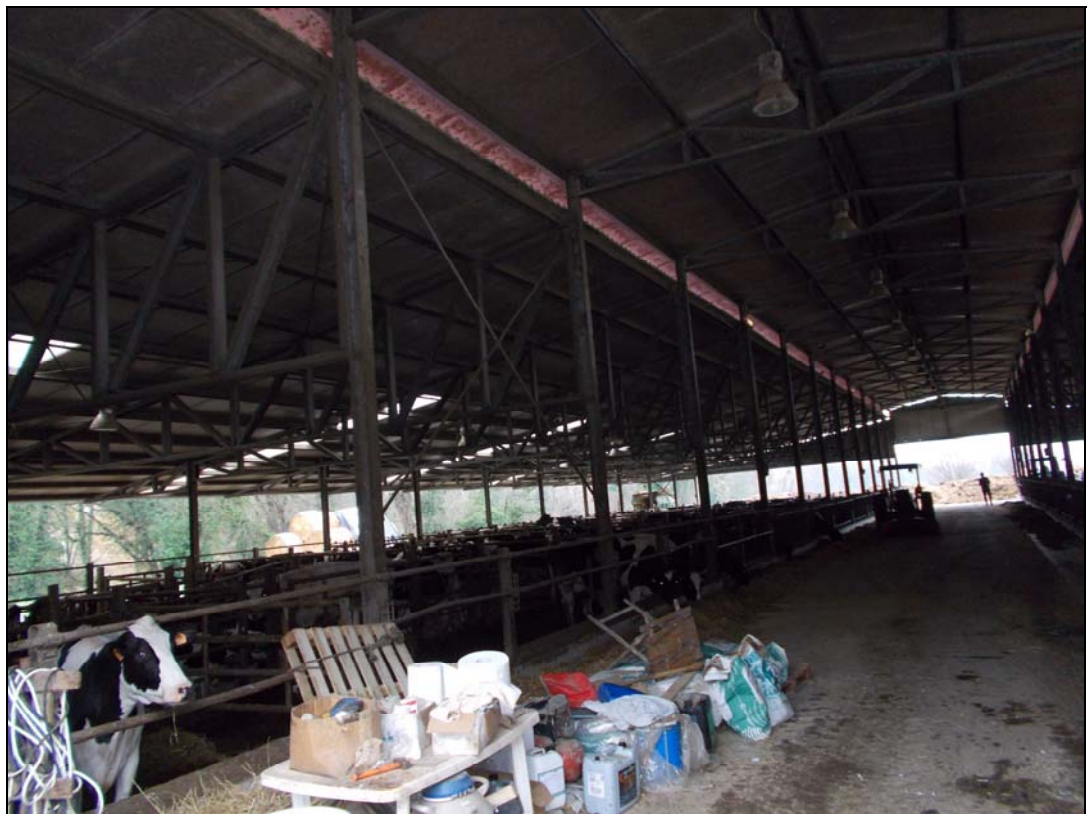
Foto n.8 (interno stalla lato Sud)
