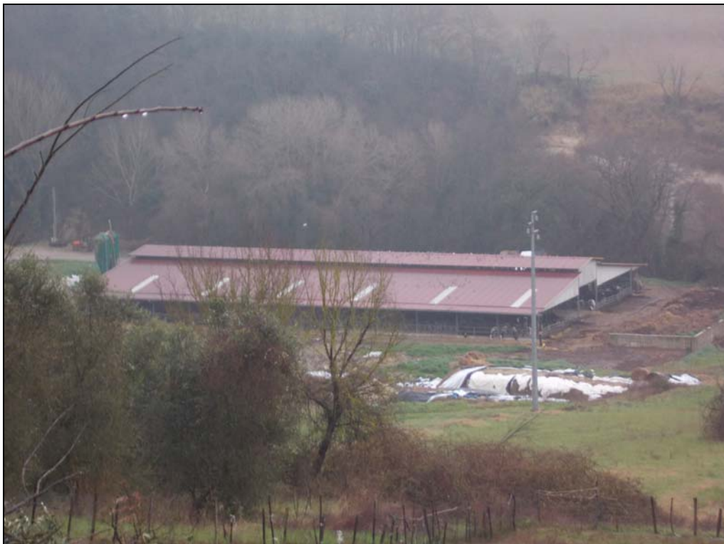
Foto n.2 (tettoia uso stalla e terreno pertinenziale)
