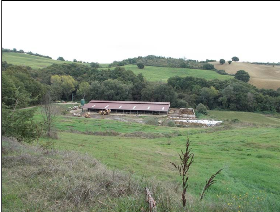
Foto n.1 (tettoia uso stalla e terreno pertinenziale)
