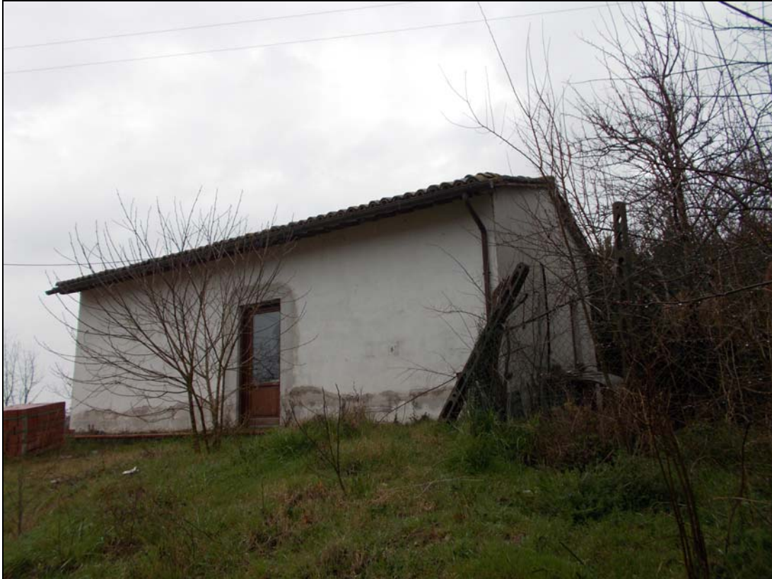
Foto n.3 (prospetto Sud - Ovest)
