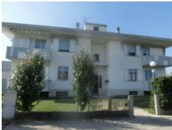
Particolare prospetto lato Est
