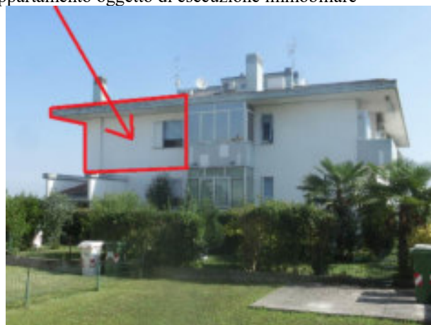
particolare prospetto lato Sud
