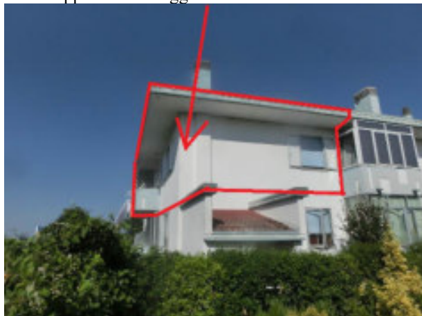
ulteriore particolare lato Sud
