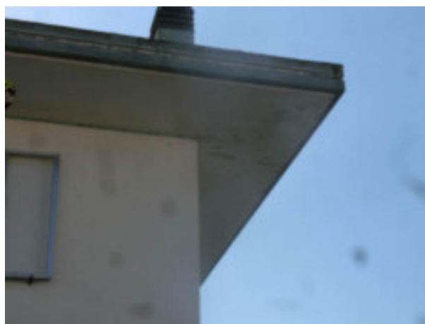
particolare grondaia e tinteggiatura esistente
