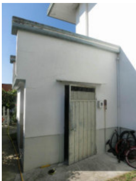
particolare ex locale caldaia comune
