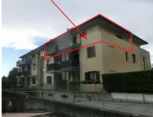
particolare prospetto lato Nord-Est
