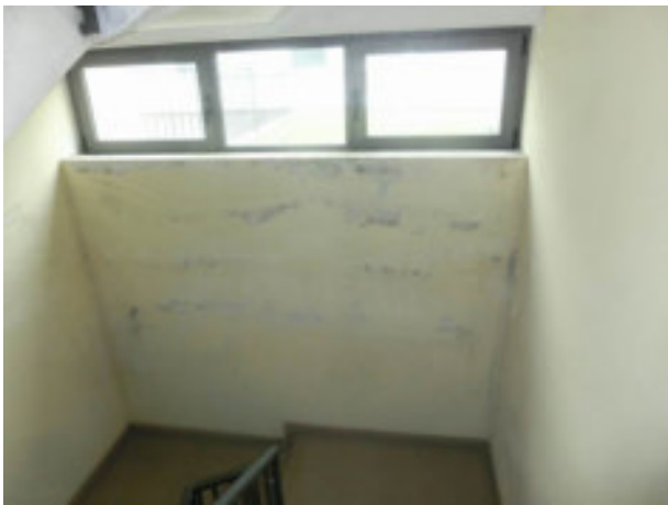
particolare vano scala al piano seminterrato
