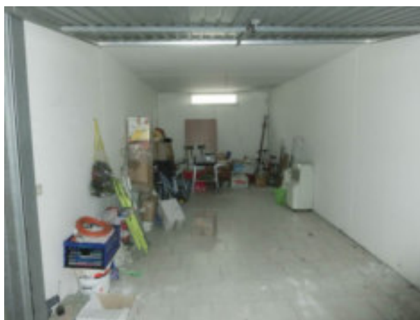
particolare autorimessa al piano seminterrato sub. 16
