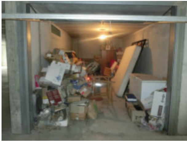
particolare autorimessa al piano seminterrato sub. 4
