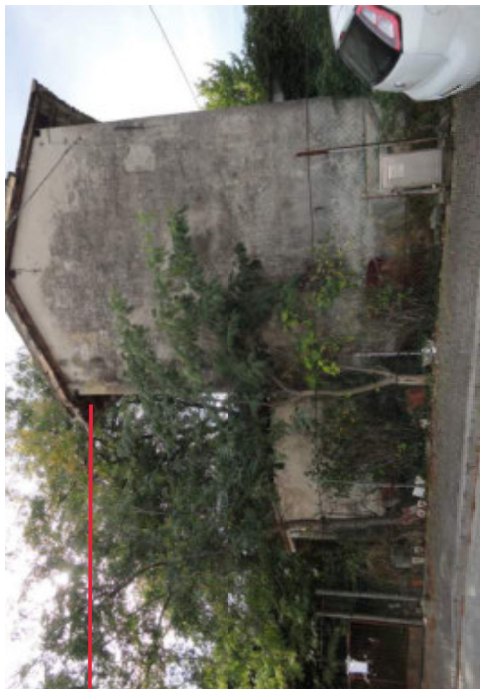
Segni di evidente deterioramento delle strutture lignee anche in copertura, riscontrabili, per quanto visibile, anche lungo il perimetro della linda, con segni di cedimenti.
