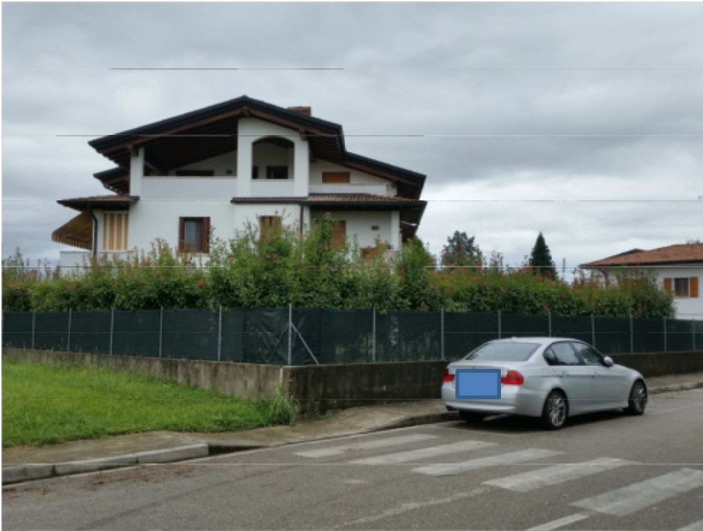
Vista del condominio
