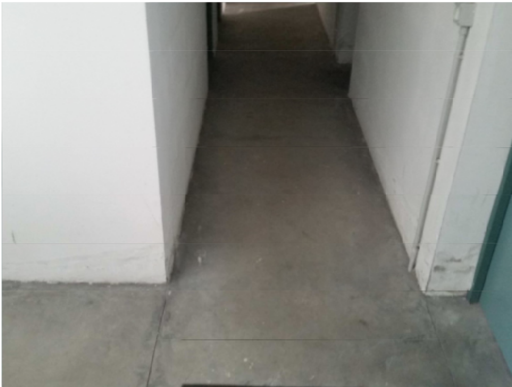
Alcune delle macchie di umidità presenti nel corridoio dell'interrato
