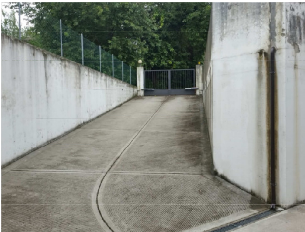
Rampa che dal corsello di manovra conduce all'accesso carraio
