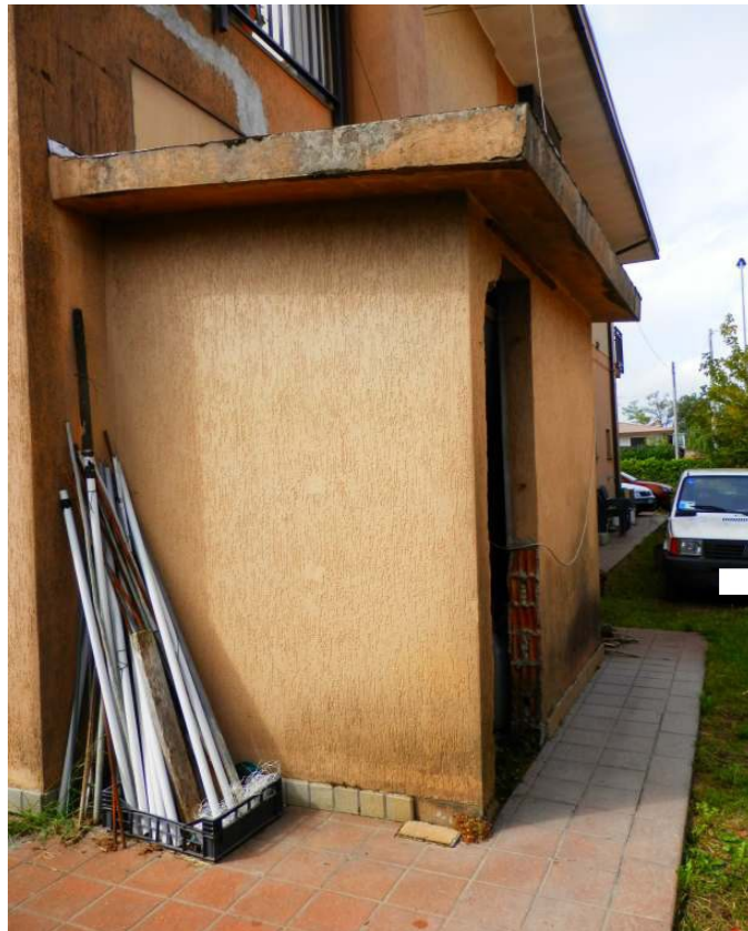
CENTRALE TERMICA DA DEMOLIRE
