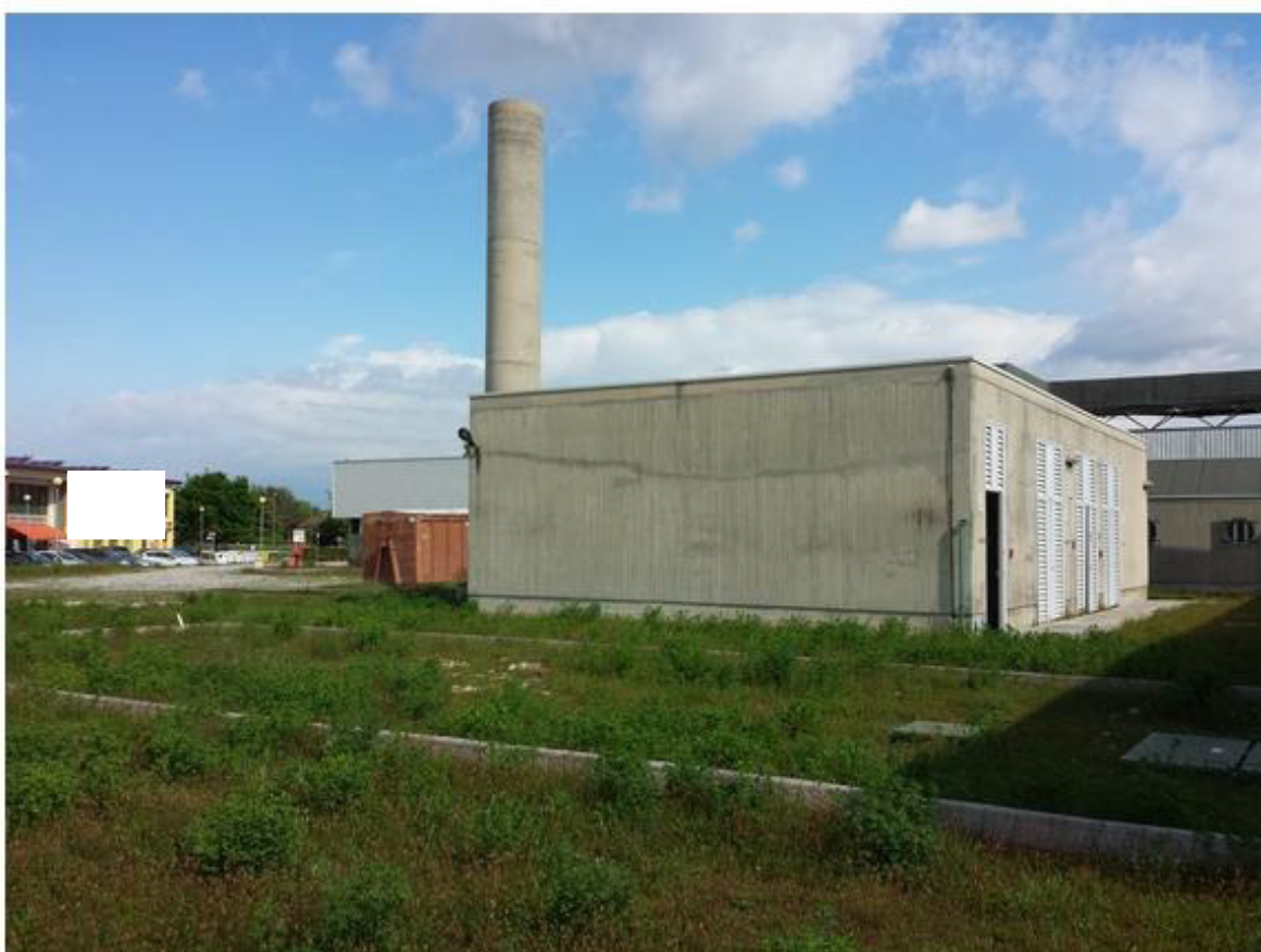
12- centrale termica e cabina elettrica retro
