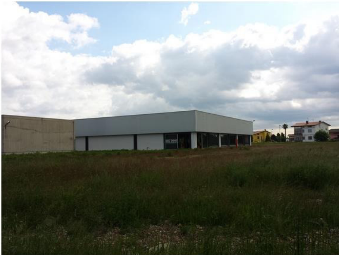
13- ala sud fabbricato
