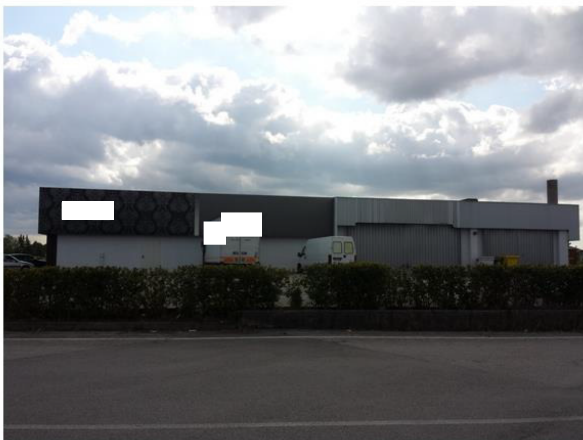
3- facciata ovest fabbricato
