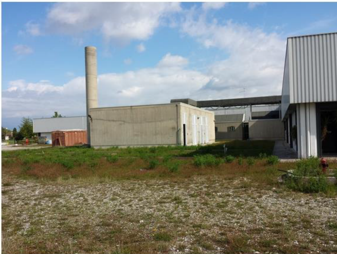
11- esterno verso CT e cabina elettrica
