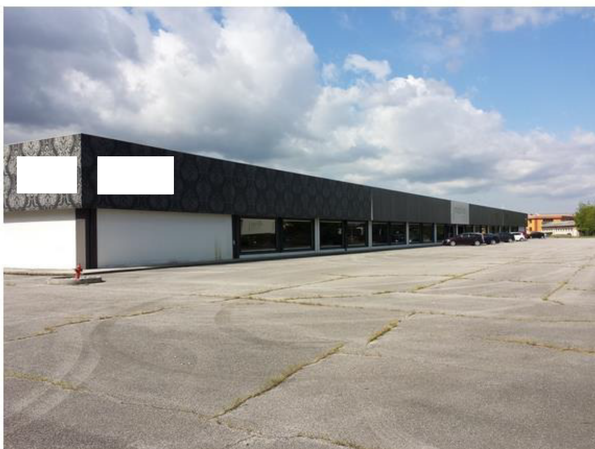
1- fronte fabbricato da est
