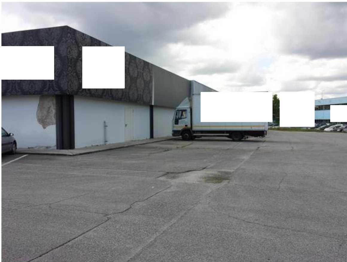
17- lato ovest fabbricato
