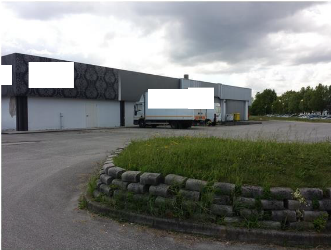
16- lato ovest fabbricato da accesso carraio
