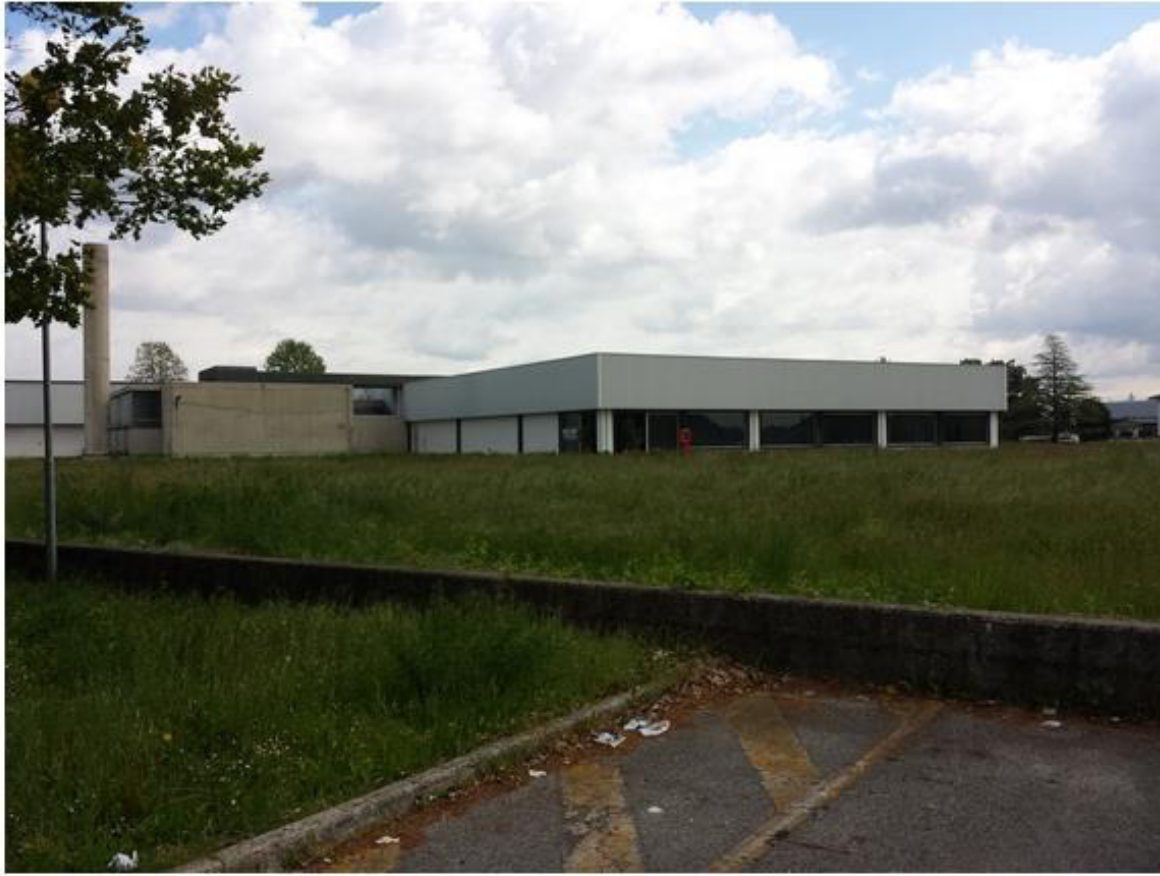
4- esterno ed ala sud fabbricato
