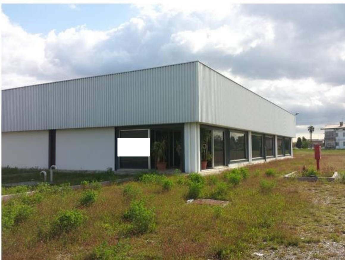
9- lato sud esterno fabbricato
