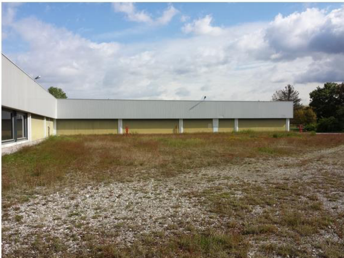
6- esterno ala sud est
