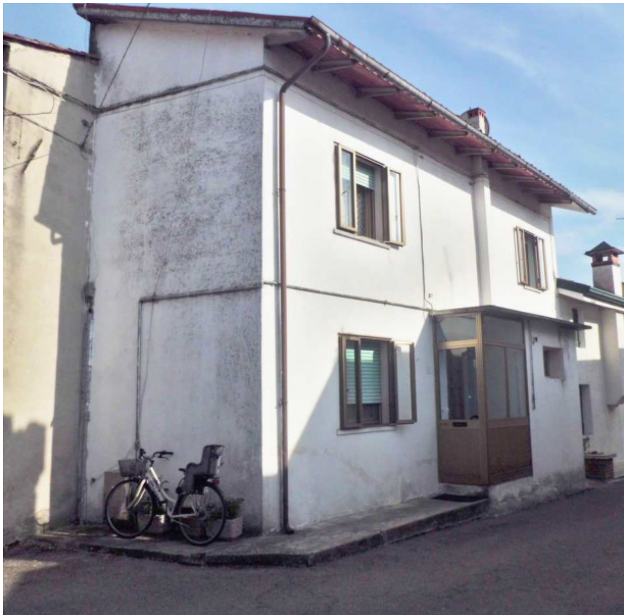
Foto n° 1 - 30/03/2017 - Comune di Cordovado, foglio 6, part. 110 – Visione esterna del fabbricato pignorato ricadente sulla particella 110. Foto scattata da via Peraredi.
