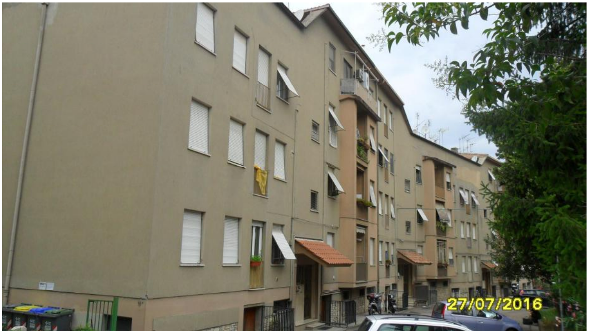
esterno fabbricato - prospetto est
