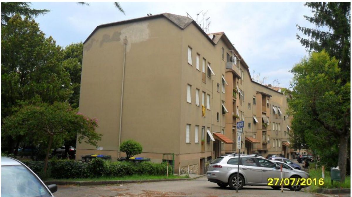
esterno fabbricato - prospetti sud ed est
