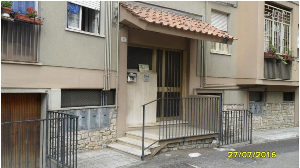
esterno fabbricato - prospetto est (ingresso al vano scala del civico 8)
