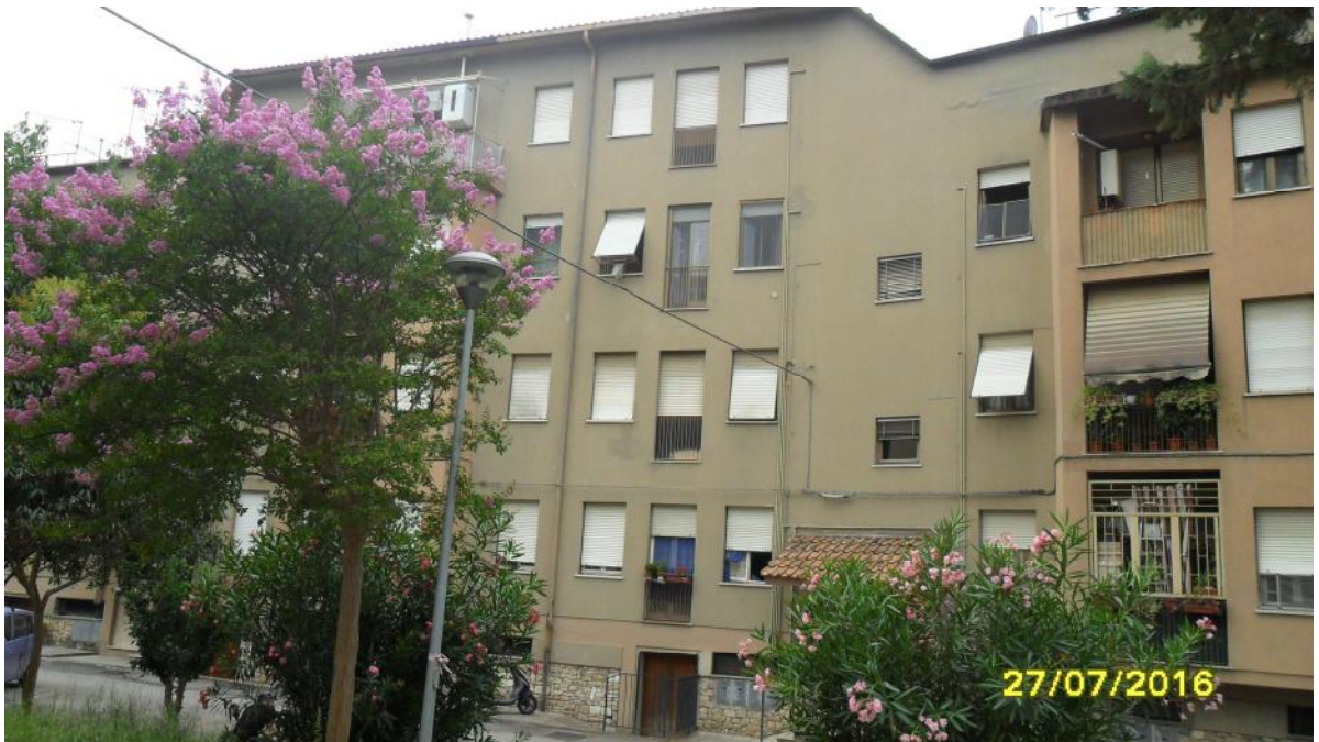
esterno fabbricato - prospetto est
