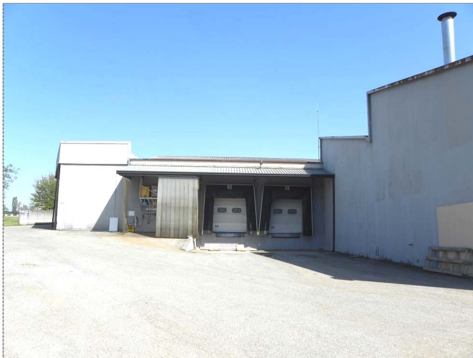
Compendio produttivo: vista lato Sud (tettoie e bocche di carico)
