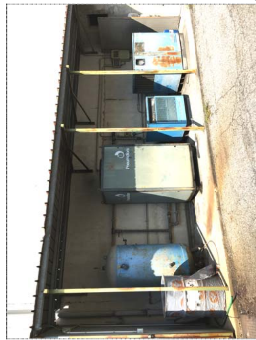
2) riscaldamento lavorazione: generatore aria calda 4) aria compressa: stazione compressione/essiccazione
