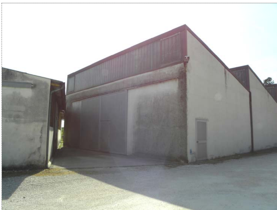
Magazzino: vista angolo Nord/Ovest
