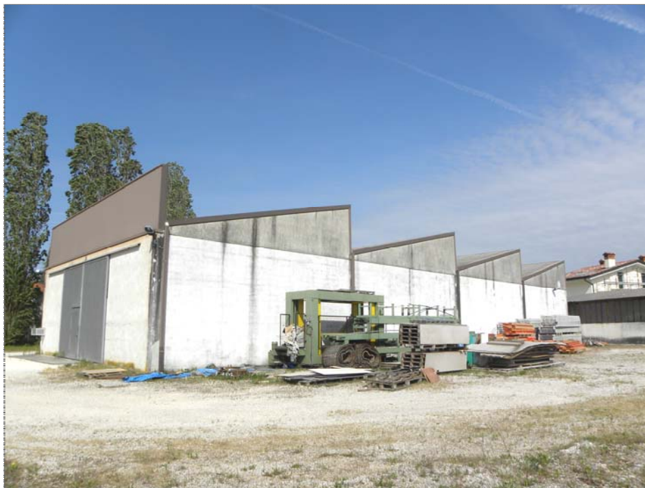
Magazzino: vista angolo Sud/Est
