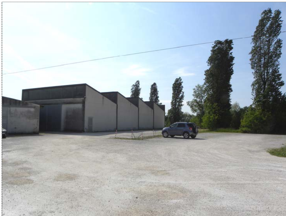
Magazzino: vista fronte strada (lato Nord/Est e piazzale)
