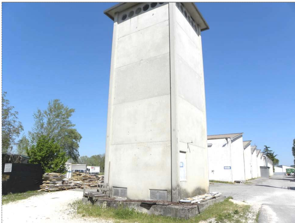
Compendio produttivo: cabina elettrica (Sud/Ovest)
