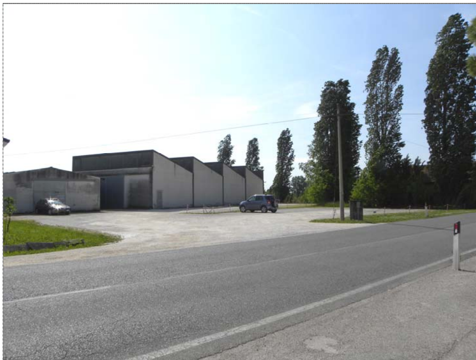
Magazzino: vista piazzale/parcheggio sul fronte
