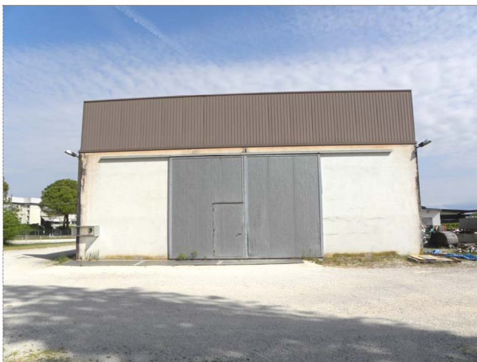
Magazzino: vista lato Sud
