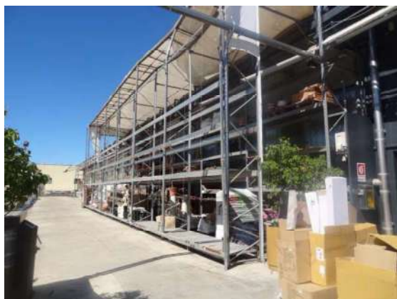
Tettoia lato sud p. T
