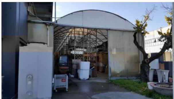
Tettoia p. T
