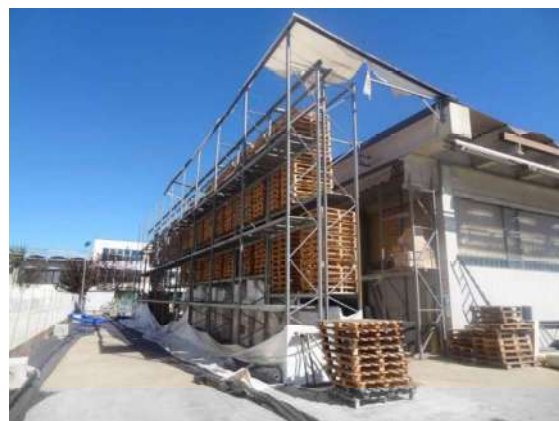
Tettoia lato ovest p. T
