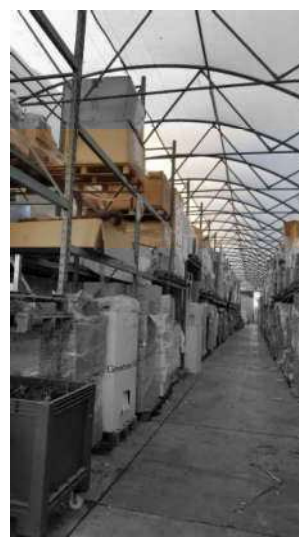
Tettoia p. T
