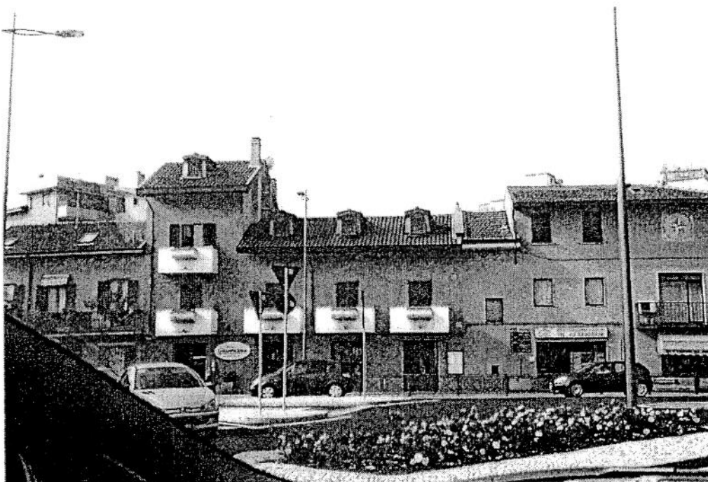
Affaccio su strada
