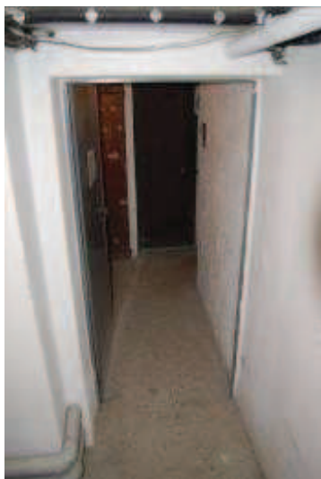
Foto 13: porta di accesso alle cantine
