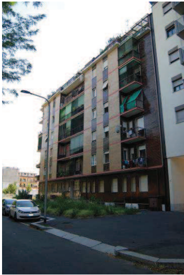
Foto 1: edificio dalla via Pesaro
