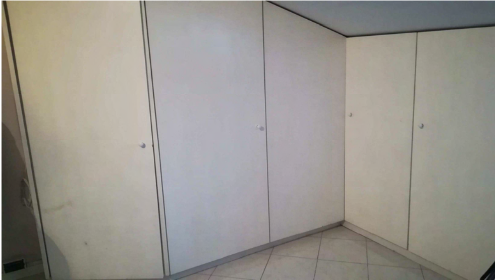
13-armadio a muro sottotetto
