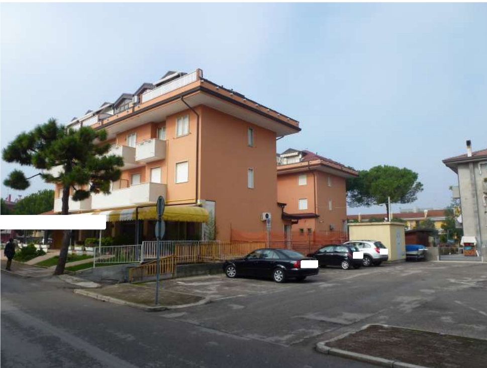
Fronte sud (via Tagliamento)
