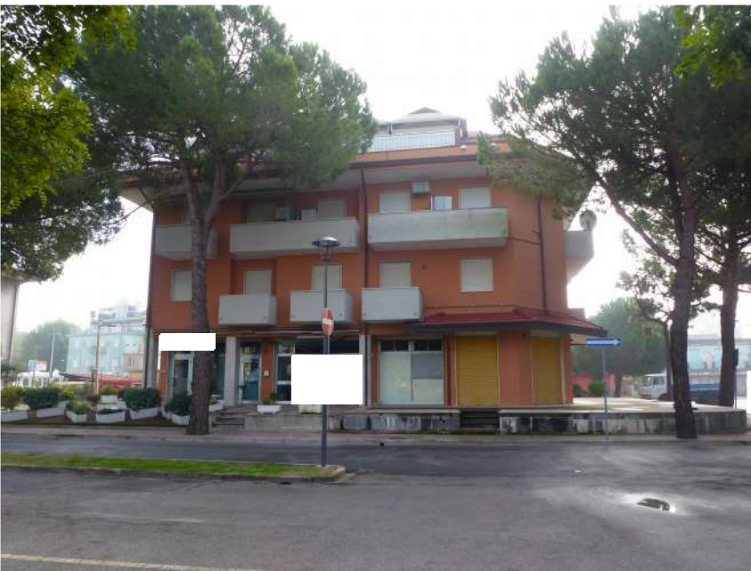
Fronte nord (Via Adige)
