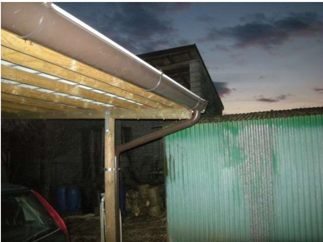
Travesio, via Garibaldi n. 27 - La tettoia.
