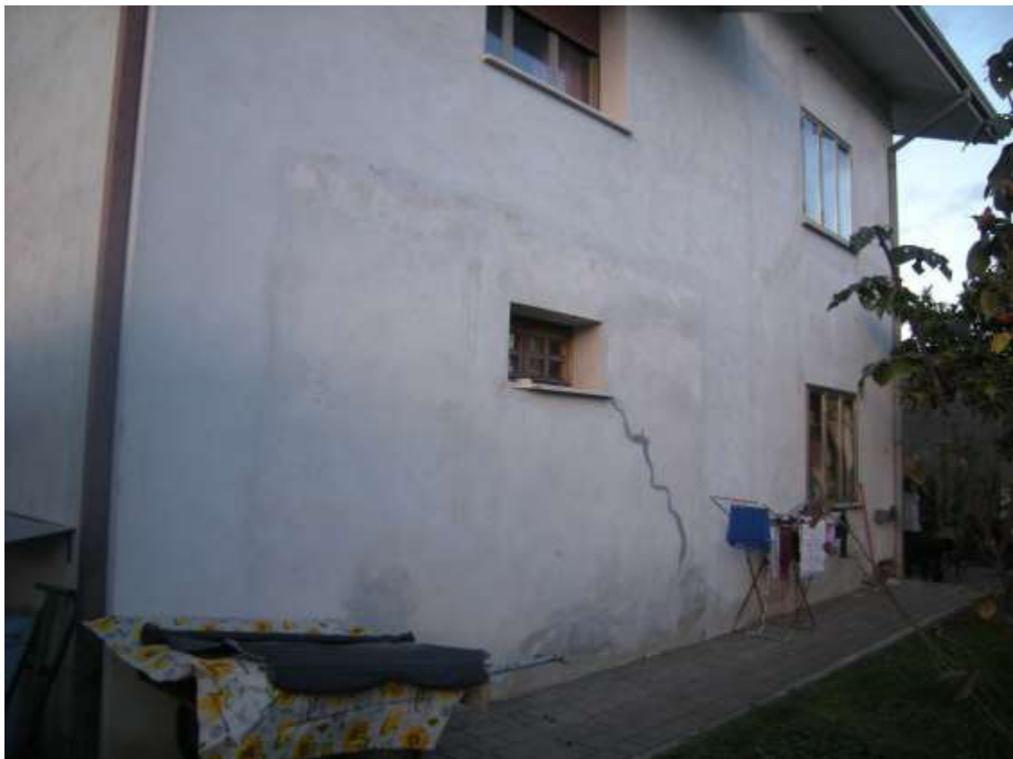
Travesio, via Garibaldi n. 27 – Il prospetto sud dell'edificio.
