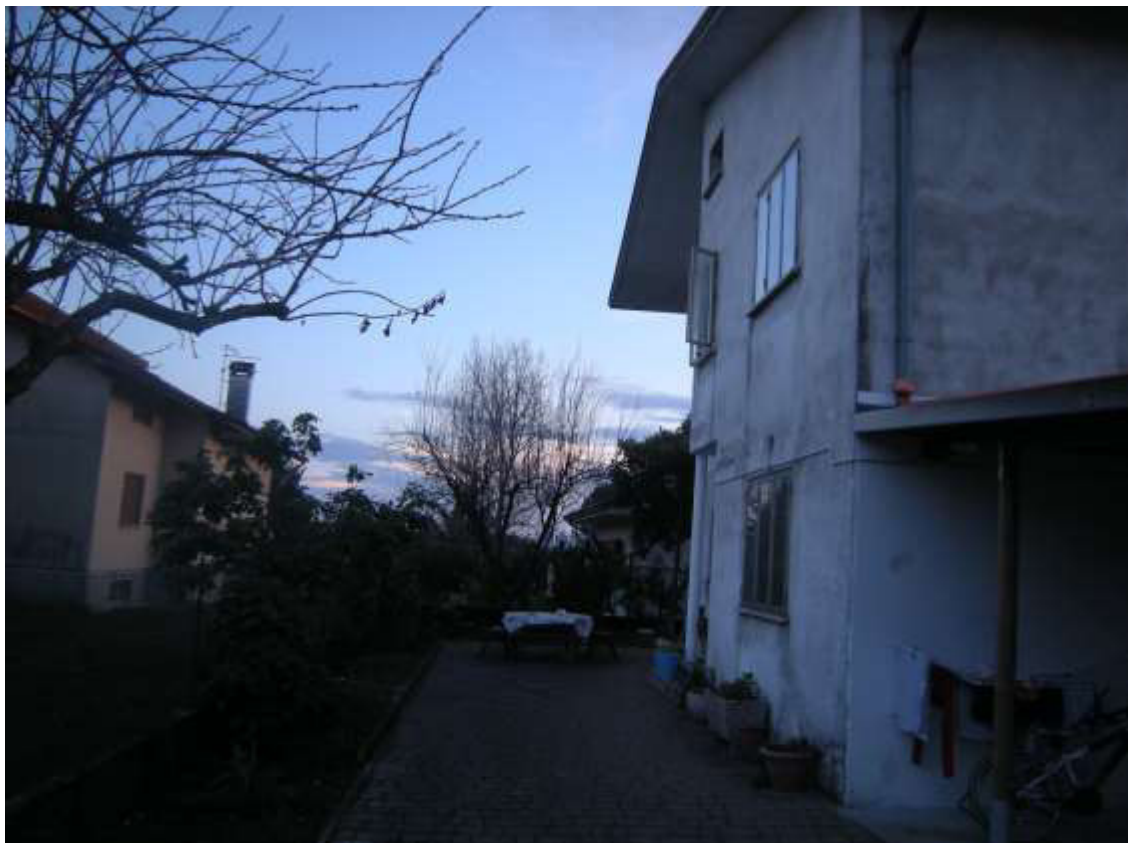
Travesio, via Garibaldi n. 27 - Il prospetto est dell'edificio.
