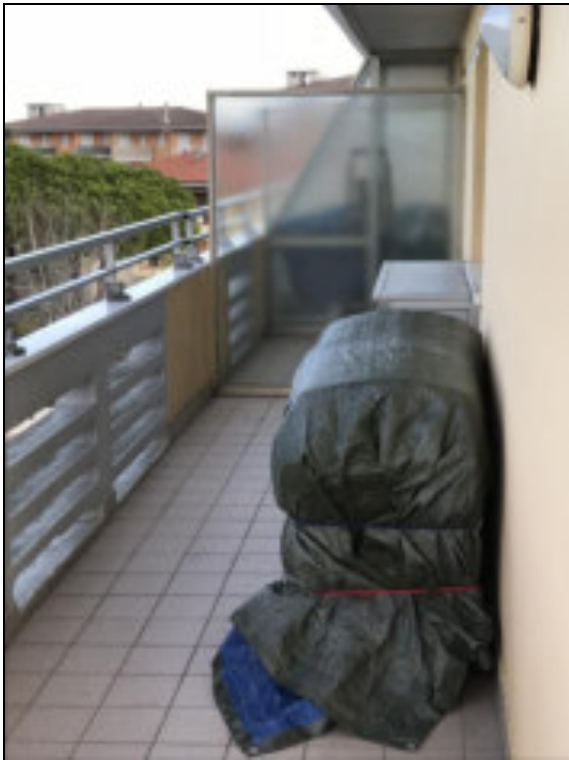
Fig.25: terrazzo a nord - ovest
