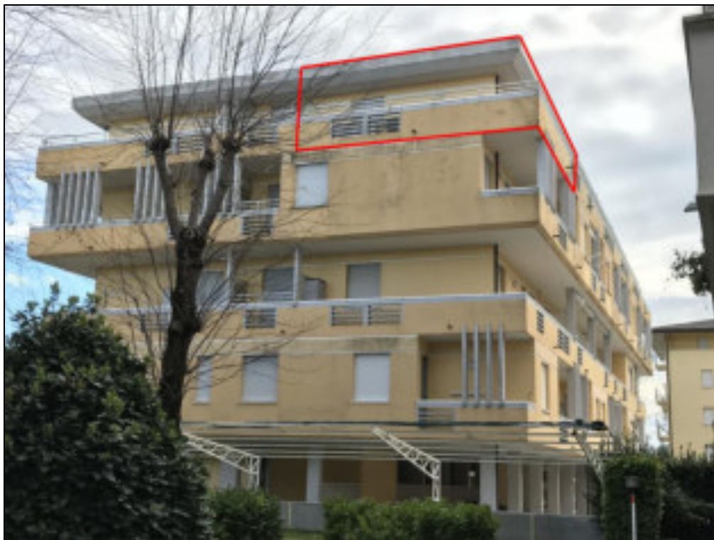
Fig.3: vista da nord - ovest
