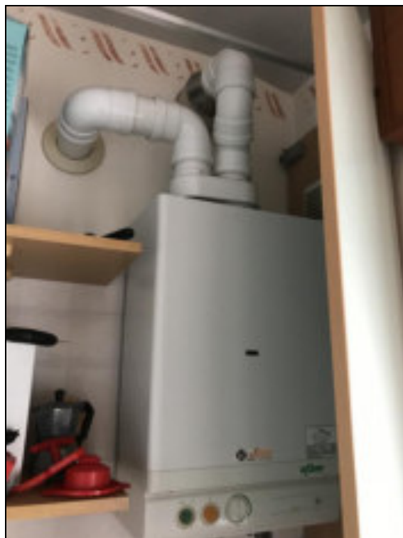
Fig.20: scaldabagno integrato nel mobilio della cucina
